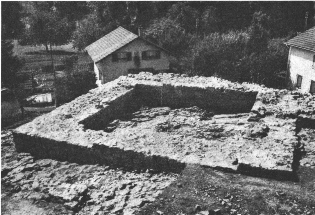
Turm (Baustrakt II) von Nordosten (119).
