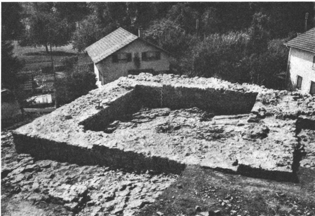
Turm (Baustrakt II) von Nordosten (119).
