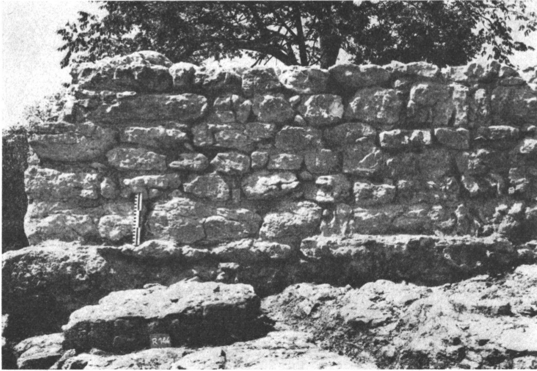
Turm, Mauerwerk von Südosten (144).
