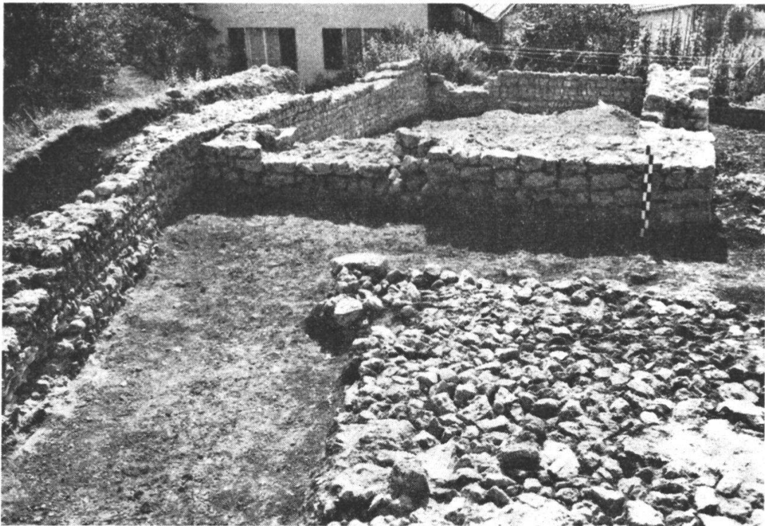
Ostrakt (Baustrakt III), Ansicht von Nordwesten. Im Vordergrund Teile des Baustraktes I (116).
