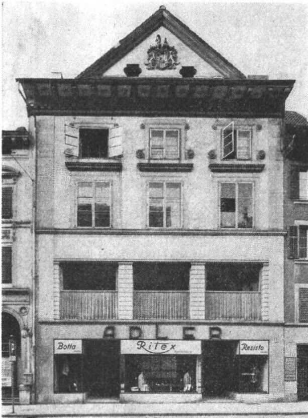
12 Solothurn: Fassade des Geschäftshauses Adler (Tugginerhaus), Gurzelngasse 25, vorher.
