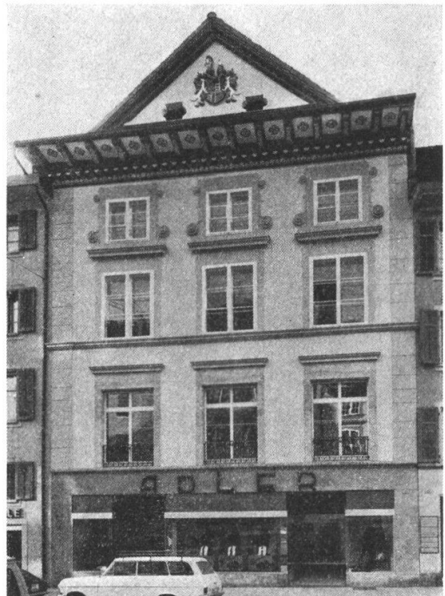
13 Solothurn: Dieselbe Fassade nach der Wiederherstellung der Fensterreihen im 1. Stock.
