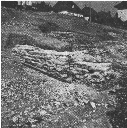
Olten, römische Villa. Strebemauer des westlichen Anbaus, gegen Nord-Osten Foto O. Lüdin
