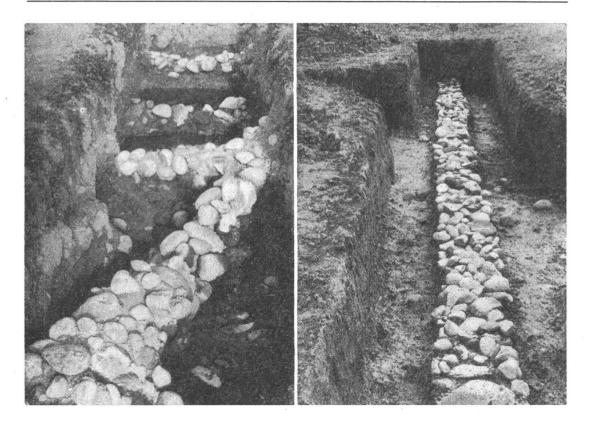
Fig. 2. und 3. Aeltere Abzugskanäle.
