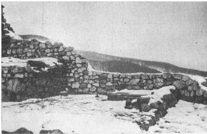
Abb. 10. Vordere Burg, Küche mit Feuerstellen.
