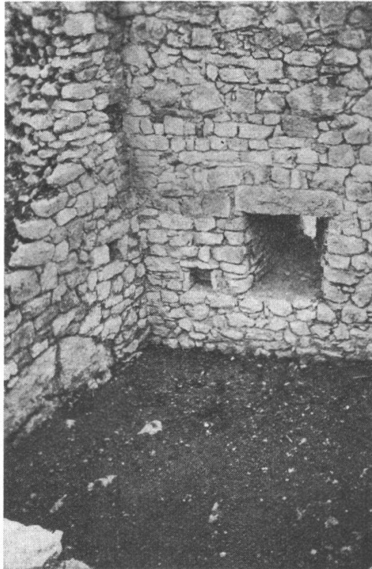
Abb. 3. Hintere Burg, Südwestecke innen.
