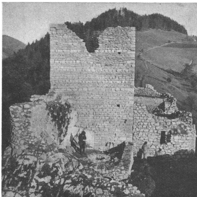
Abb. 5. Vordere Burg, Westseite Turm.
