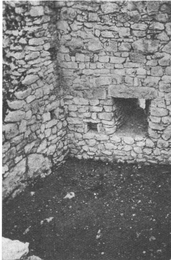
Abb. 3. Hintere Burg, Südwestecke innen.
