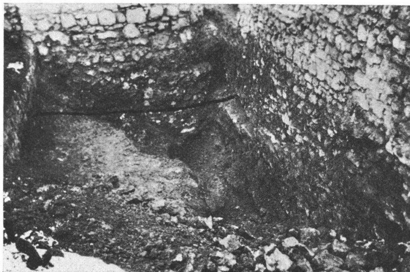
Abb. 6. Vorderburg, unterer Teil der Mauer bei Punkt 10.
