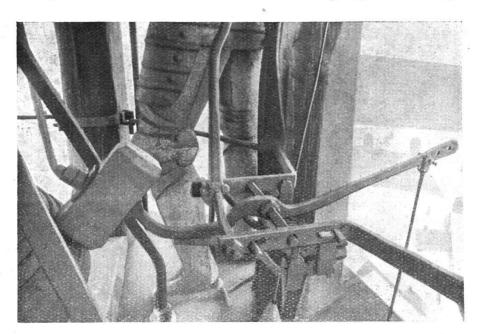
Abb. 31. Das Hammerwerk des Viertelschlagwerkes.
