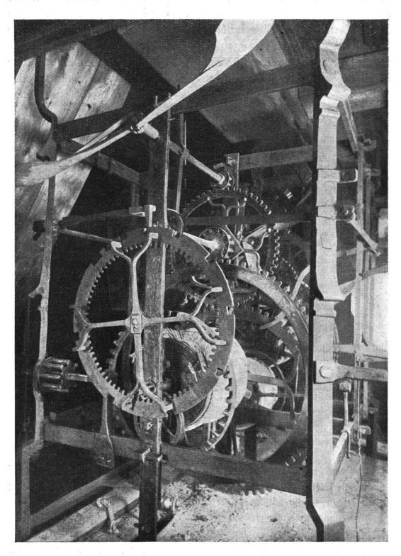
Abb. 33. Schlußscheibe und Windfang des Stundenschlagwerkes.
