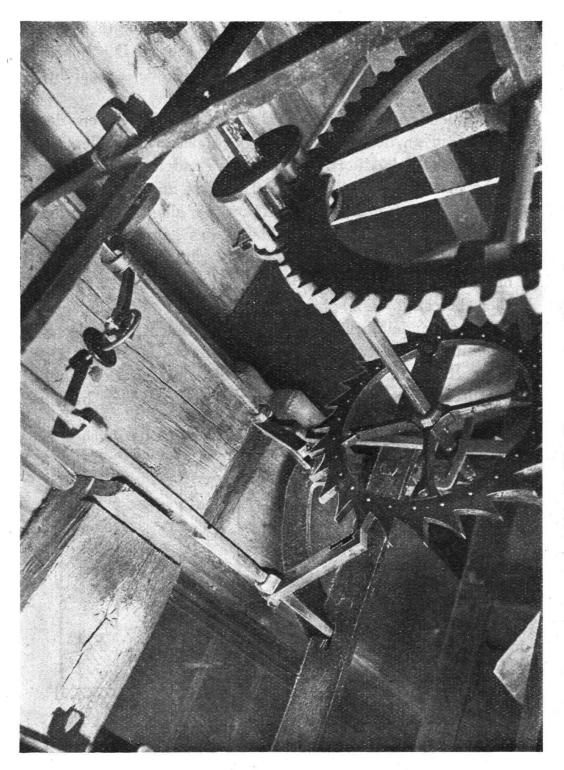
Abb. 18. Die Hemmung des Gehwerkes. Ein Steigradzahn wirkt auf die Ausgangspalette auf Antrieb.
