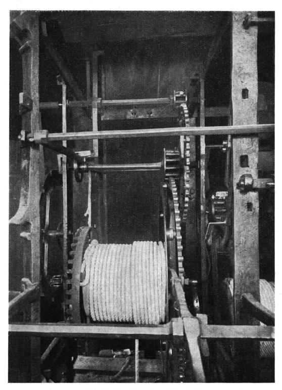
Abb. 32. Das Stundenschlagwerk.
