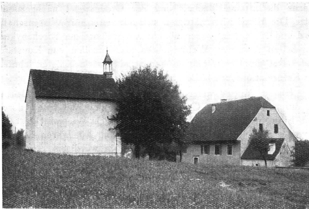
Propstei Rohr im heutigen Zustand.
