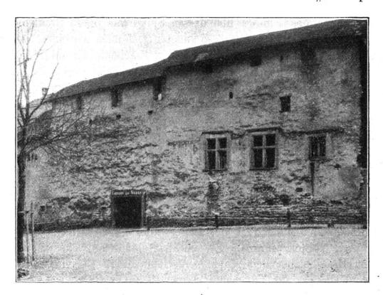
Fig. 19. "Rittersaal" mit Wallgang und römischer Fundation in der nördlichen Stadtmauer.
