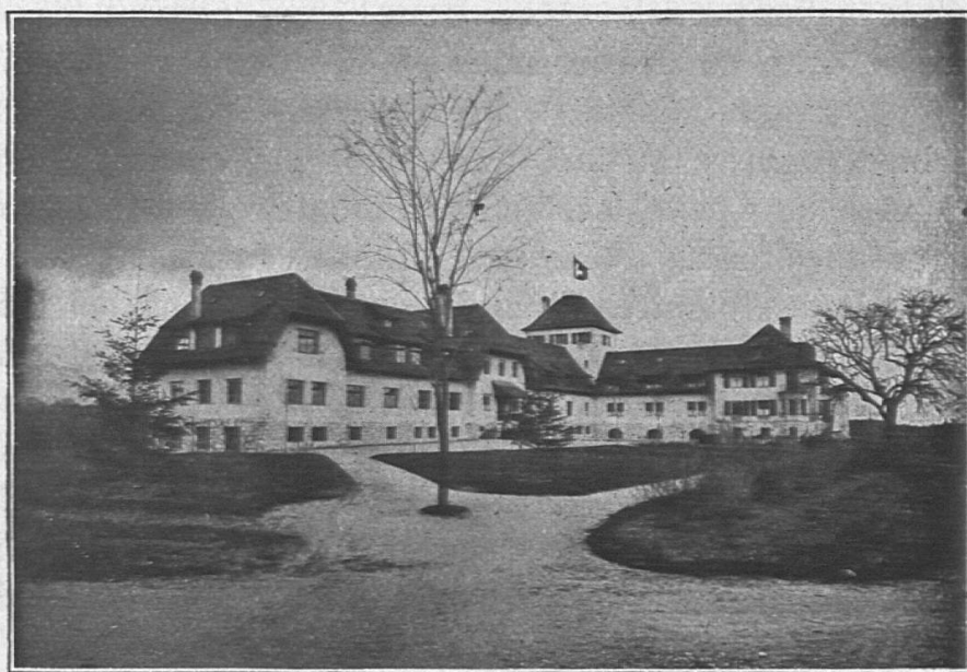
Châtaigneraie. — L'ensemble des bâtiments vu du sud-ouest. A gauche l'école, au centre les dortoirs, à droite la villa du directeur.
