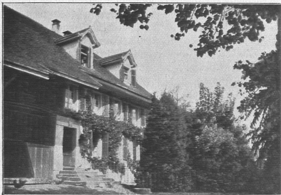
Hallwil. — La maison d'habitation et la ferme vues du sud.
