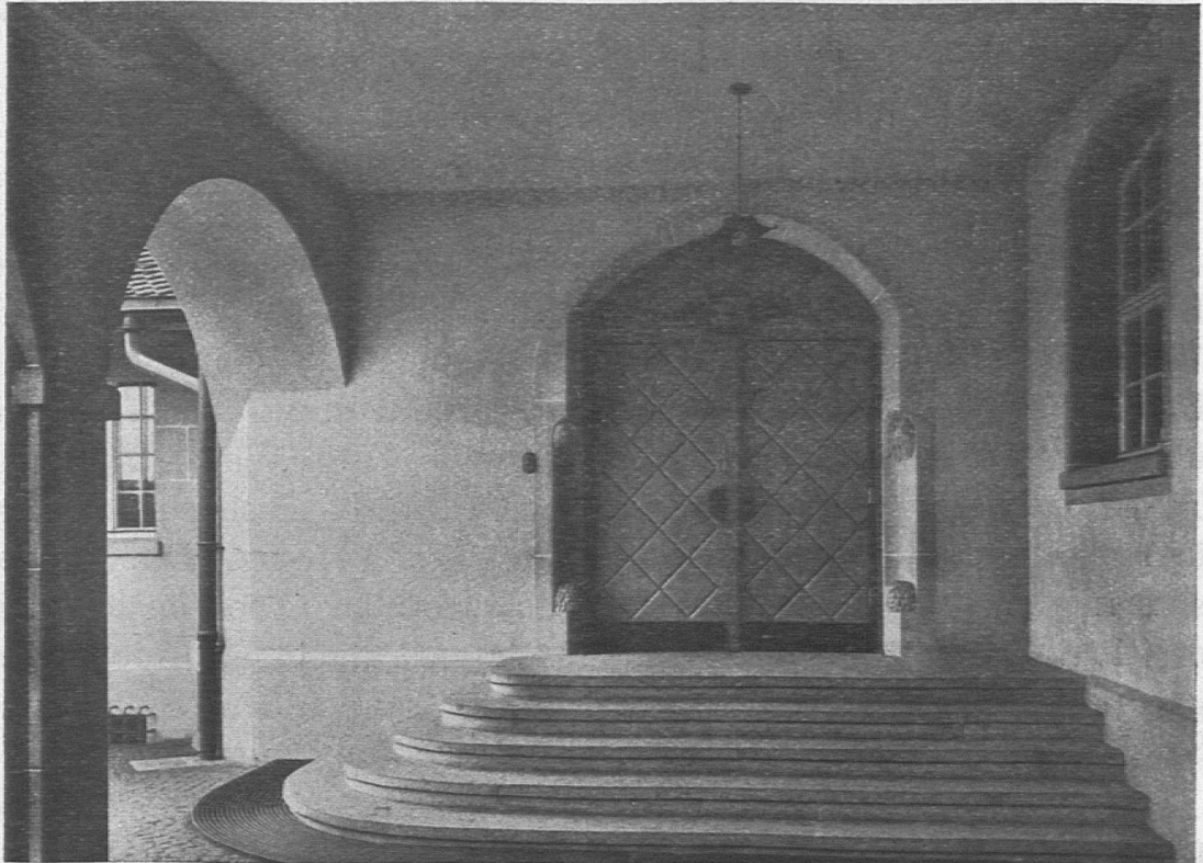
Primarschulhaus Breitfeld Bern. Hauptportal.
