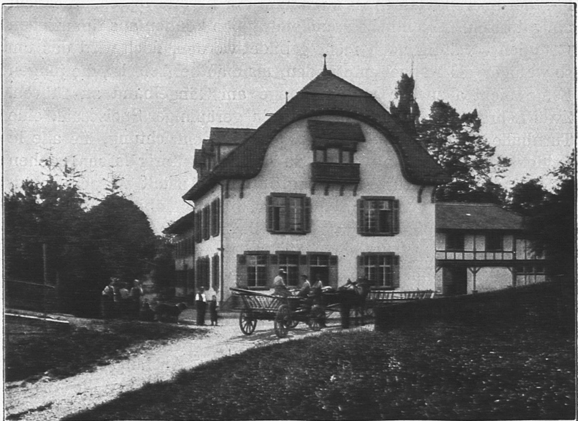
Kantonale Erziehungsanstalt Klosterfiechten bei Basel: Hauptgebäude.
