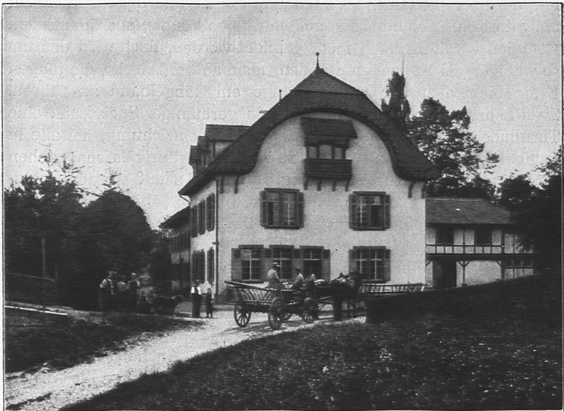
Kantonale Erziehungsanstalt Klosterfiechten bei Basel: Hauptgebäude.
