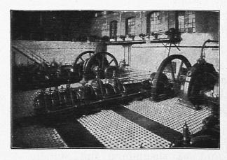
Bewässerungsanlage Wadi-Com-Ombo (Ägypten) (Sulzer-Ventil-Dampfmaschinen).
