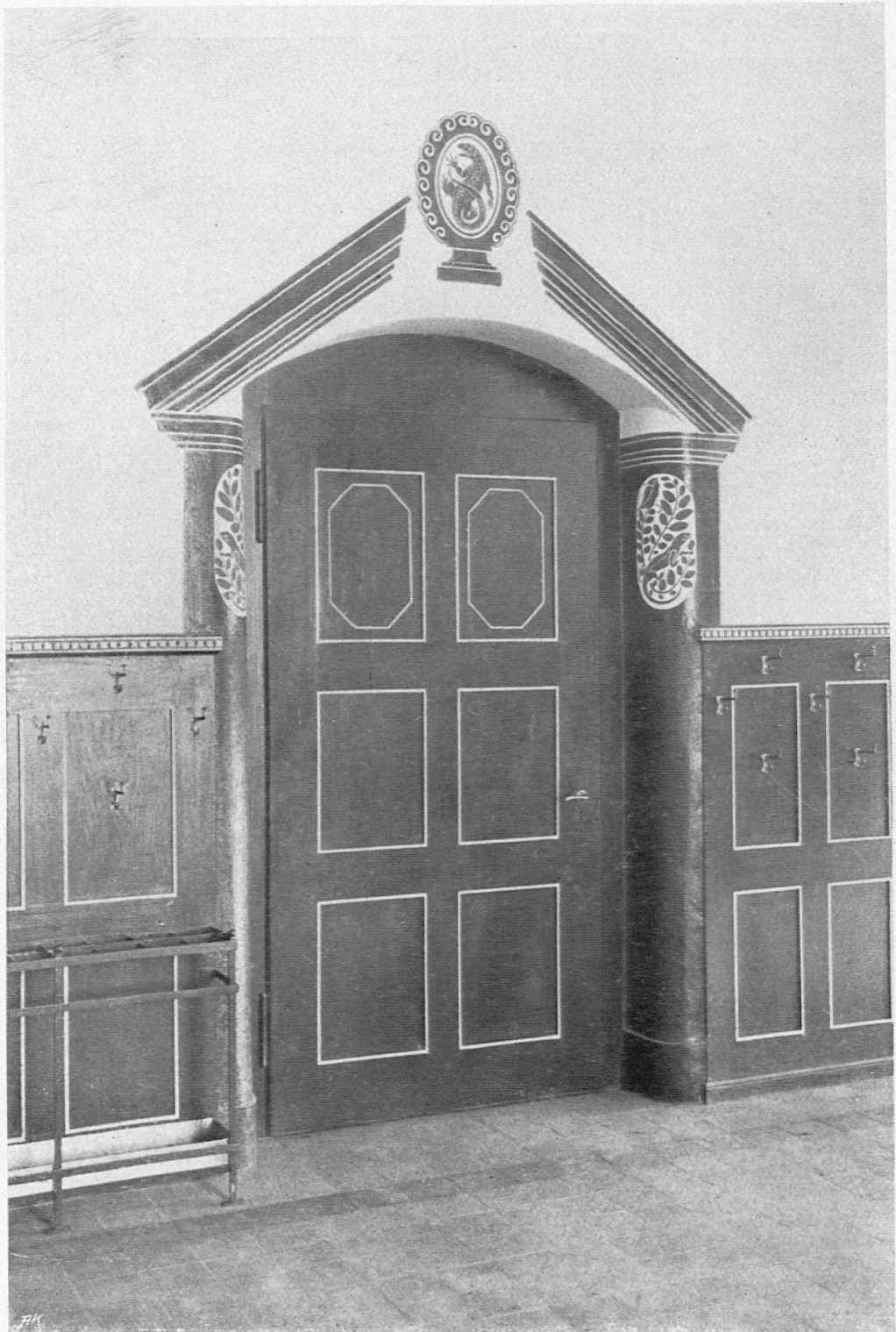
Schulzimmertüre im Gang des I. Stockwerkes. Holzwerk rot gestrichen in gewellter Pinselführung, durch Linien und Ornamente (Tierreich) in gebrochenem Weiss belebt. Architektur-Umrahmung rot aufgemalt.
