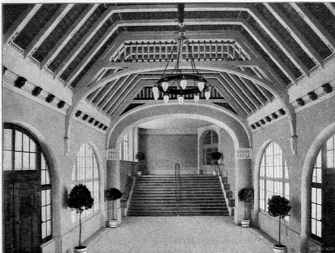
Primarschulhaus Hermesbühl Solothurn: Eingangshalle.
