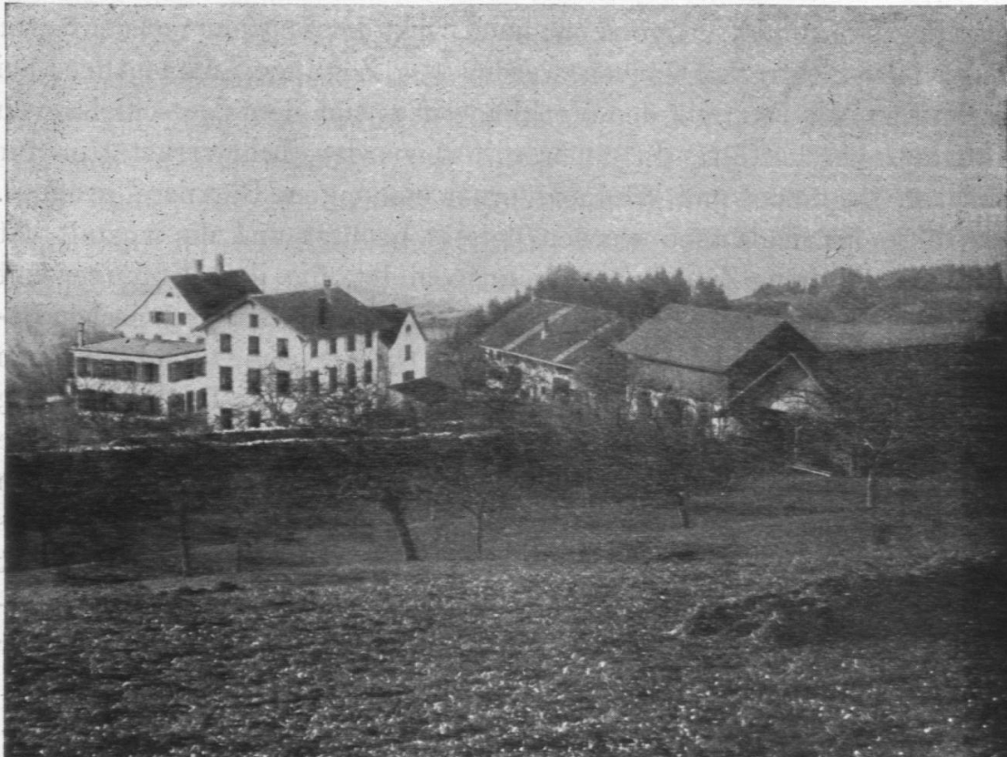
Kantonale Korrekptionsanstalt Ringwil.
