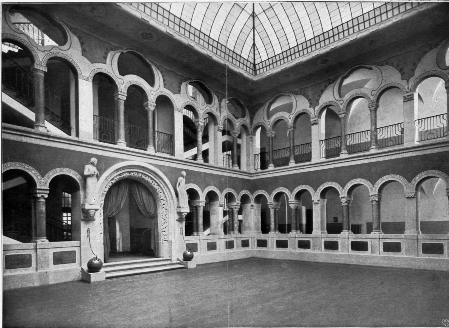
Höhere Töcherschule in München. Aula und Turnhalle.
