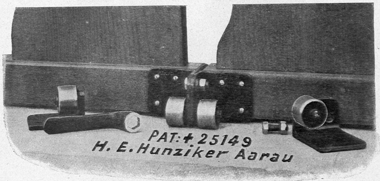
Fig. 6. Rollenkuppelung von H. E. Hunziker in Aarau.
