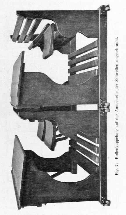
a) Bei schweren Bänken in Eisenkonstruktion durch die sehr praktische Rollenkuppelung von E. H. Hunziker in Aarau. (Fig. 6.) Durch diese Erfindung können alte und neue Schultische mit Holzschwellen jeden Systems zu festen Zügen verbunden und seitlich verschoben werden, so dass ein Längsstreifen des Zimmerbodens ganz freigelegt wird. (Fig. 7.)
