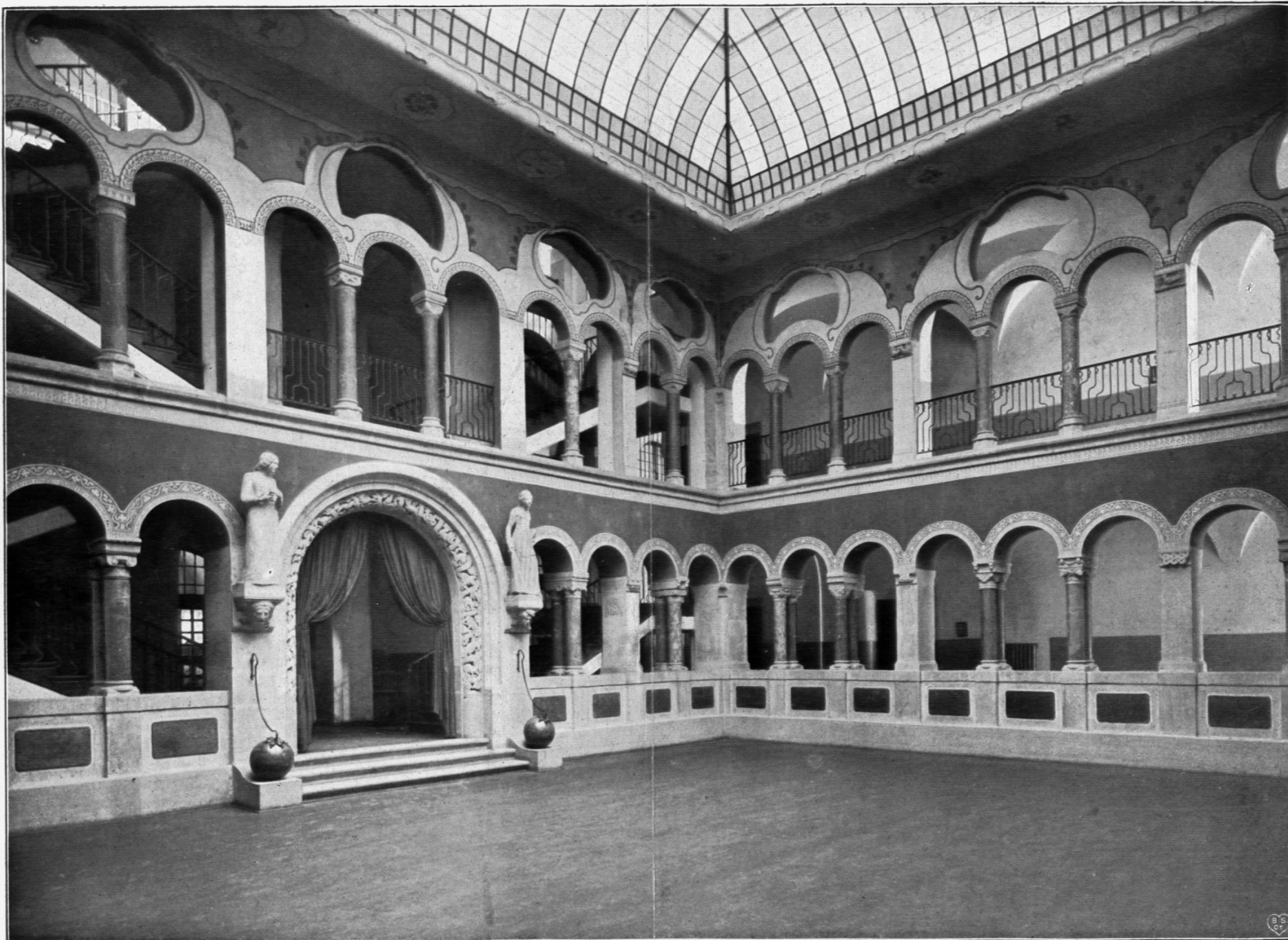
Höhere Töchterschule in München. Aula und Turnhalle.
