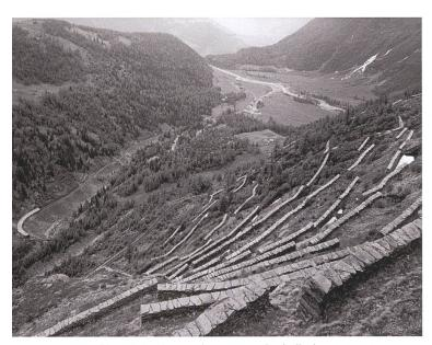
Abb. 17: Lawinenverbauungen oberhalb der sogenannten Pila-Kehre, ca. 1925 (© Archiv RhB).
