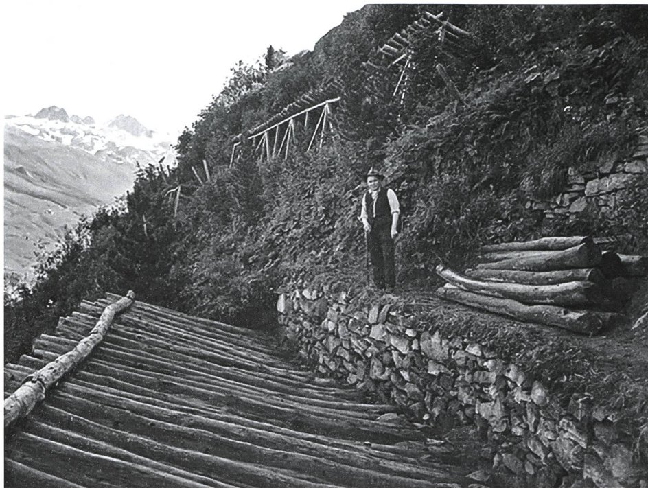
Abb. 35: Schneerechen und Mauerterrasse im «Hotelzug» am Gurschen, Sommer 1936. (StAUR, 128.16-BI-4529)
