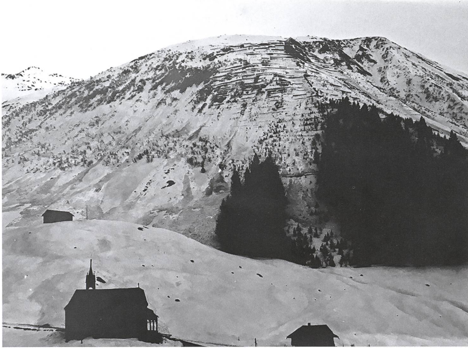
Abb. 36: Blick in Richtung Gurschen mit Ursernwald (Bannwald) und alten Mauerterrassen, freistehenden Bruchsteinmauern sowie Verpfählungen, April 1924. Gemeindearchiv Andermatt, 22/2 (1). Verbauungen Gurschen 1931–1951.
