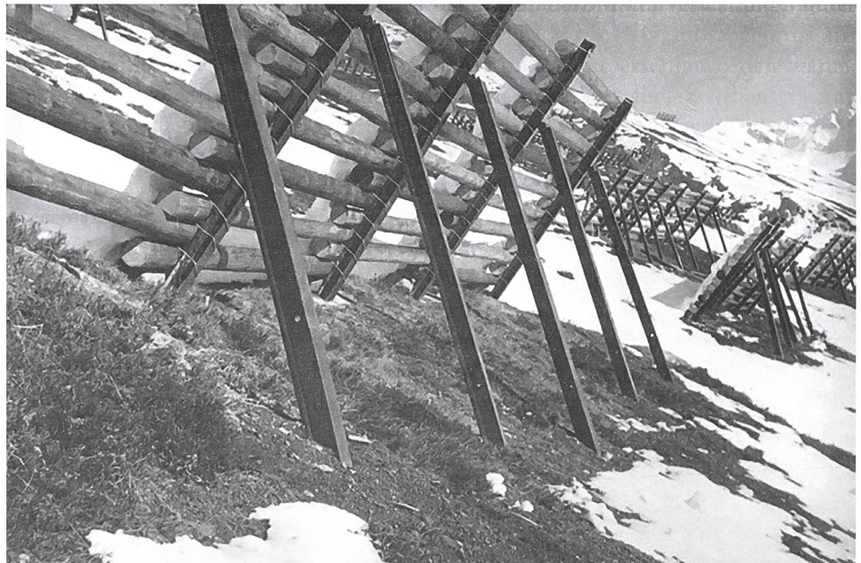
Abb. 50: Schneebrücken aus Eisenbahnschienen und Rundhölzer im Verbauungsgebiet Ob Stafel-Ost, wie sie häufig auch am Gurschen errichtet wurden. (Gemeindearchiv Andermatt, 22/3 (1): Fotografien Karl Oechsli. Lawinerverbauungen Kirchberg Andermatt 1952–1957. Gebaute Werke 1951/54)
