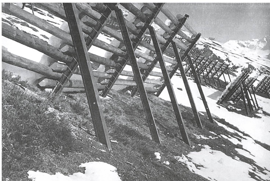
Abb. 50: Schneebrücken aus Eisenbahnschienen und Rundhölzer im Verbauungsgebiet Ob Stafel-Ost, wie sie häufig auch am Gurschen errichtet wurden. (Gemeindearchiv Andermatt, 22/3 (1): Fotografien Karl Oechslin. Lawinverbauungen Kirchberg Andermatt 1952–1957. Gebaute Werke 1951/54)
