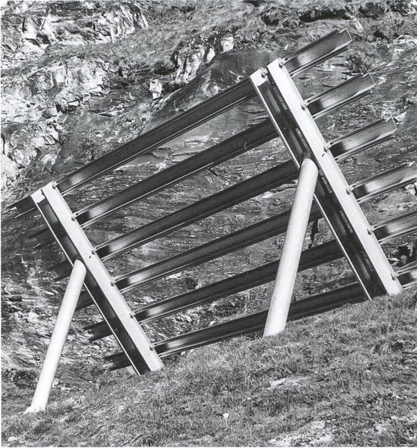
Abb. 8: Leichtmetallschneebrücke in der Lawinenverbauung «Schweifinen», Zermatt, 15. Juni 1966. Solche Schneebrücken wurden am Mattstock in Amden bereits zu Beginn der 1950er-Jahre verbaut. (Alpines Museum der Schweiz Bern, ID 17/87 Nr. 2845; Nachlass Hans Frutiger)
