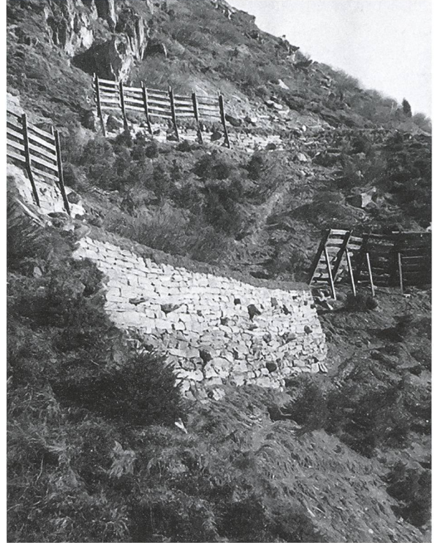
Abb. 49: Schneehäge auf Mauerterrassen in der Nassekehle, Oktober 1953; eine wirksame und kostengünstige Verbauungsvariante am Gurschen und am Kirchberg. (Gemeindearchiv Andermatt, 22/3 (1): Fotografien Karl Oechsli. Lawinerverbauungen Kirchberg Andermatt 1952–1957. Gebaute Werke 1951/54)
