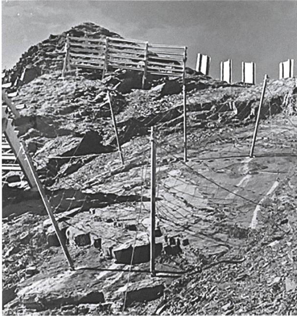
Abb. 25: Drahtseilnetzstützwerk der KWB zur Ergänzung der VOBAG-Werke am Tschatschuggen; oben rechts die Verwehungsverbauung am Grat, Herbst 1957. (BAR, E 3270 (C) 1997/72 Nr. 227)
