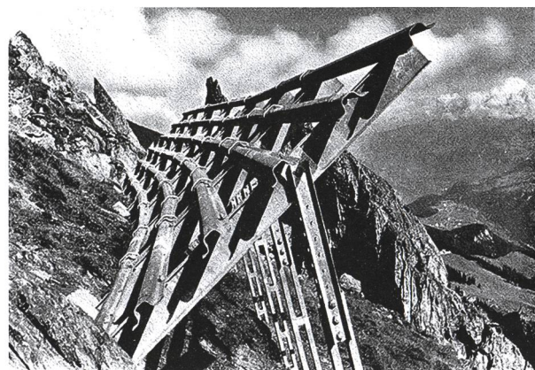
Abb. 11 Stahlstützwerk der Österreichisch-Alpine Montangesellschaft; Lawinenverbauung Munt/Truns. (FRUTIGER: Entwicklung, 1965, S. 45)
