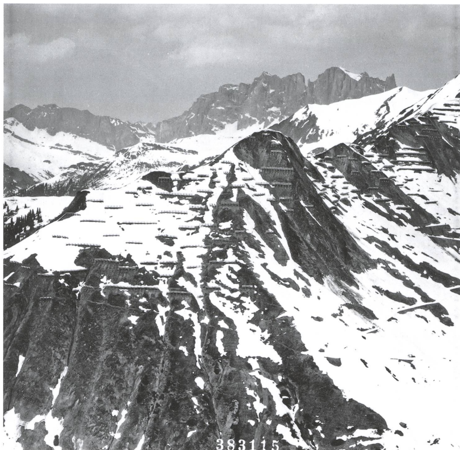
Abb. 26: Die Lawinerverbauungen am Kühnihornmassiv mit den erstellten Verbauungsgebieten I–III und teilweise IV, 10. Mai 1958. (Fotobestand Amt für Wald und Naturgefahren Graubünden (AWN); StAGR, C32.669/4)
