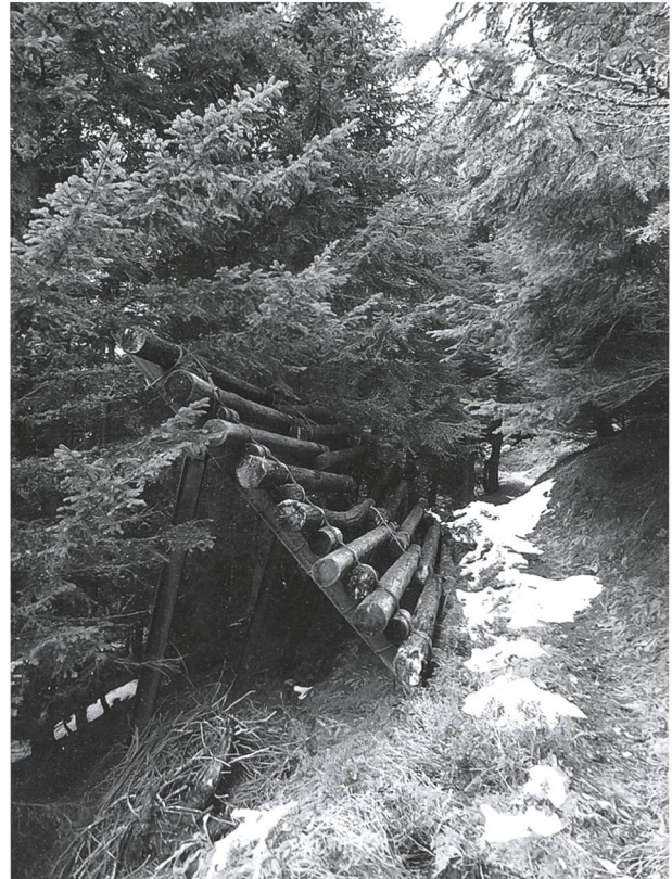
Abb. 3: Temporäre kombinierte Schneebrücke; Lawinerverbauung Kirchberg, Andermatt, September 2017. (eigene Aufnahme)
