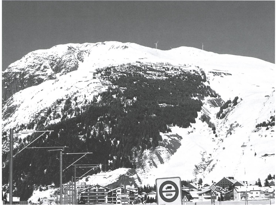
Abb. 56: Der Kirchberg mit Lawinenverbauungen, die langsam vom Schutzwald abgelöst werden, 2015. (Amt für Forst und Jagd Kanton Uri (ohne Signatur))
