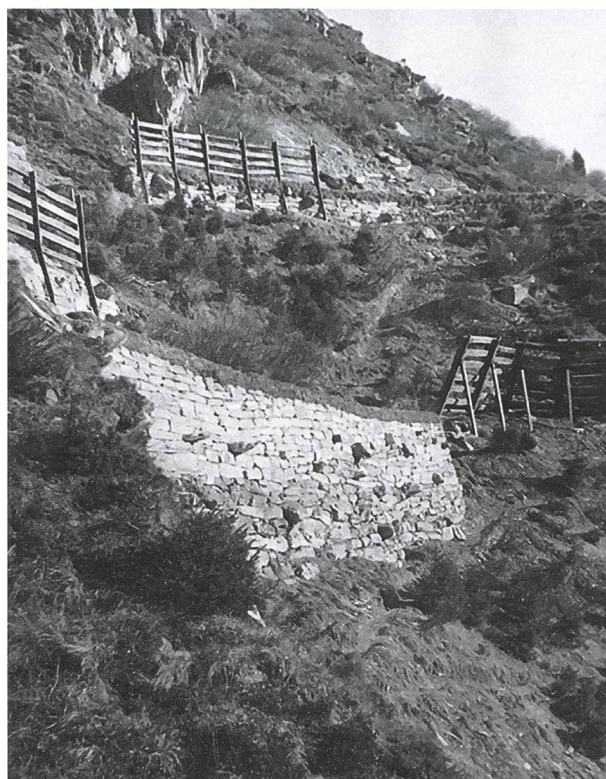
Abb. 49: Schneehäge auf Mauerterrassen in der Nassekehle, Oktober 1953; eine wirksame und kostengünstige Verbauungsvariante am Gurschen und am Kirchberg. (Gemeindearchiv Andermatt, 22/3 (1): Fotografien Karl Oechslin. Lawinverbauungen Kirchberg Andermatt 1952–1957. Gebaute Werke 1951/54)
