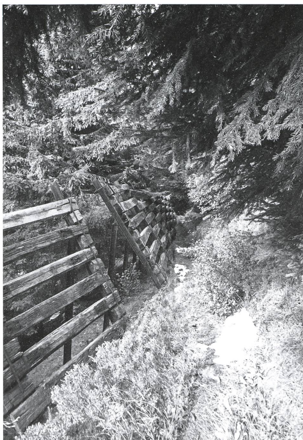
Abb. 48: Stützwerke aus Eisenbahnschienen und -schwellen, wie sie am Kirchberg häufig angewendet wurden, September 2017. (eigene Aufnahme)
