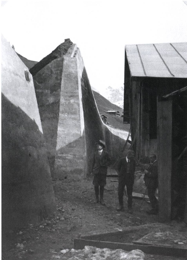
Abb. 17: Aus Beton gegossener Spaltkeil hinter einem Haus in St. Antönien (um 1935). (Fotobestand Amt für Wald und Naturgefahren Graubünden (AWN); StAGR, C32.0629/2)
