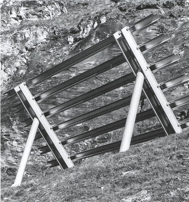
Abb. 8: Leichtmetallschneebrücke in der Lawinerverbauung «Schweifinen», Zermatt, 15. Juni 1966. Solche Schneebrücken wurden am Mattstock in Amden bereits zu Beginn der 1950er-Jahre verbaut. (Alpines Museum der Schweiz Bern, ID 17/87 Nr. 2845; Nachlass Hans Frutiger)
