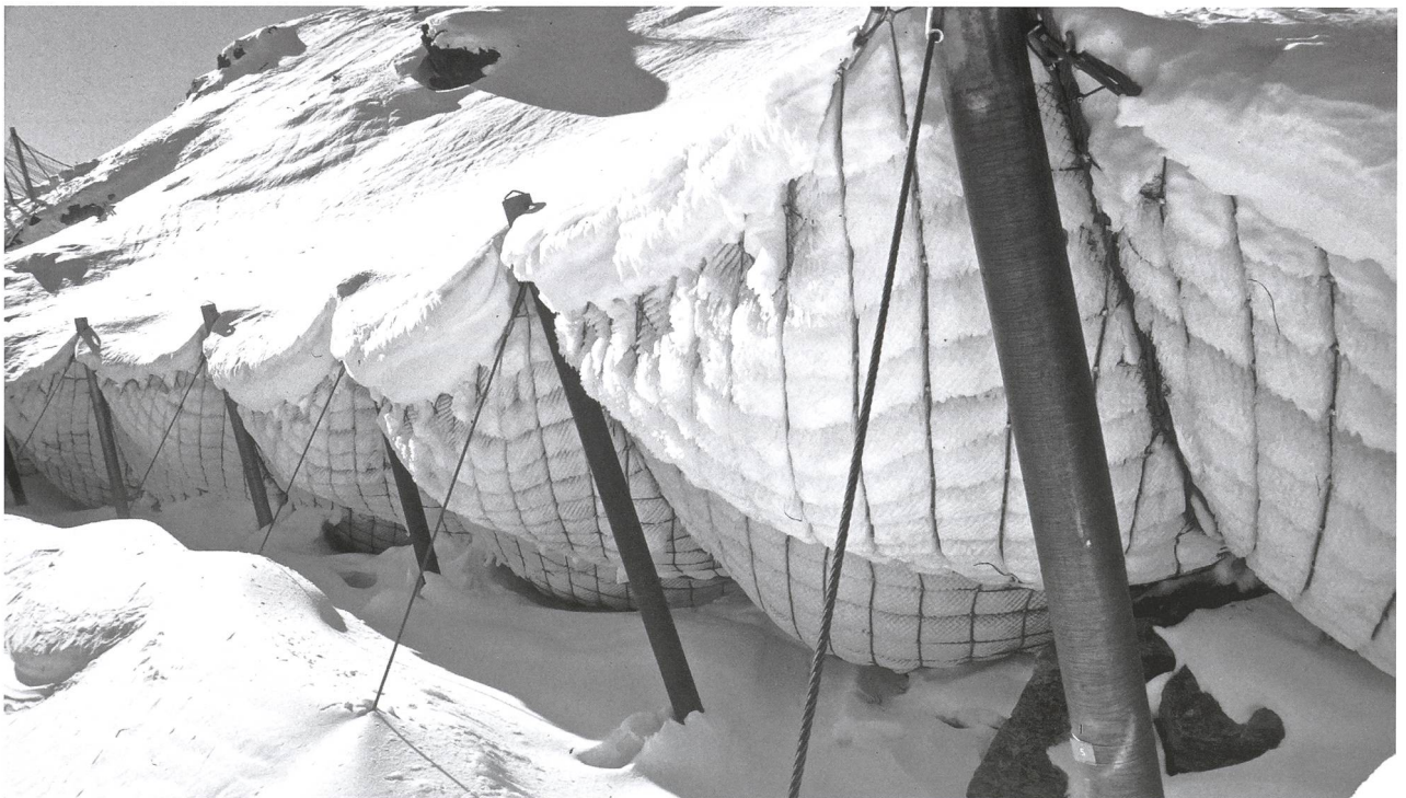
Abb. 5: Schneesetzstützwerk aus dreiecksförmigen flexiblen Drahtseilnetzen; Lawinenverbauung Duchli, Dischmatal. (Fotografie: Stefan Margreth, WSL-INSTITUT FÜR SCHNEE- UND LAWINENFORSCHUNG SLF: https://www.slf.ch/de/ueber-das-slf/portrait/geschichte/lawinenschutz.html , 13.12.2017)
