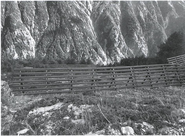
Abb. 2: Permanente Stahlschneebrücken; Lawinerverbauung Faldumalp, Goppenstein, September 2017. (eigene Aufnahme)
