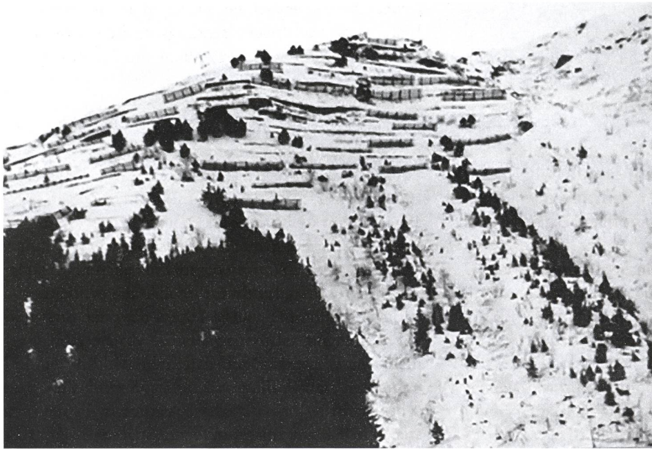
Abb. 57: Das Verbauungsgebiet Hotelzug vor den Ergänzungsarbeiten, 18. April 1963. (StAUR, R-272/1008 (9,2))
