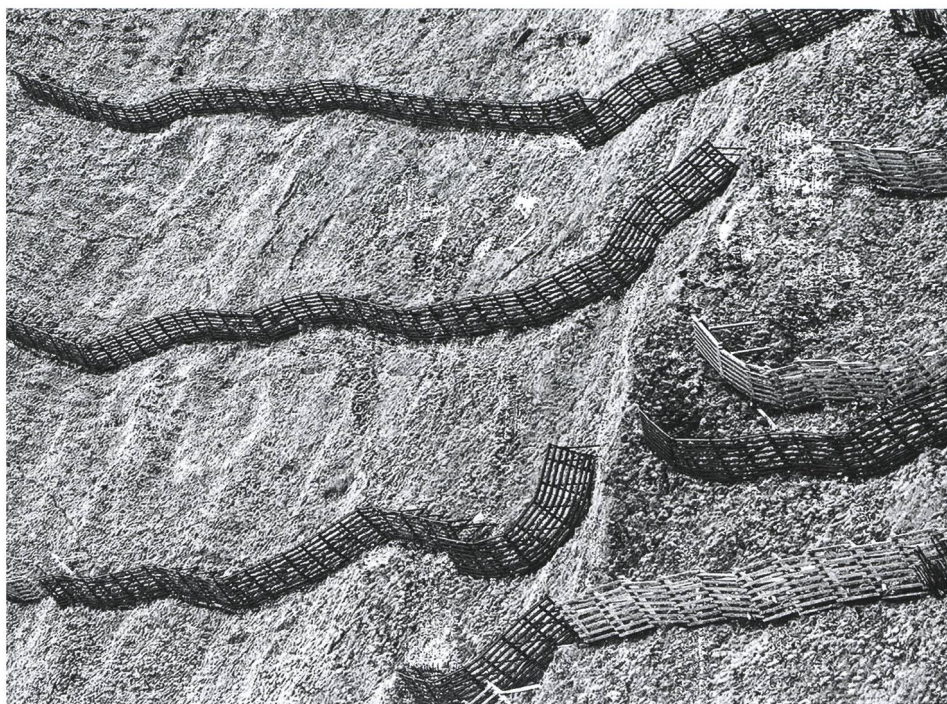
Abb. 30: Stahlstützwerke ersetzen heute teilweise die VOBAG-Stützwerke. (THALMANN: Tal, 2015, S. 25)
