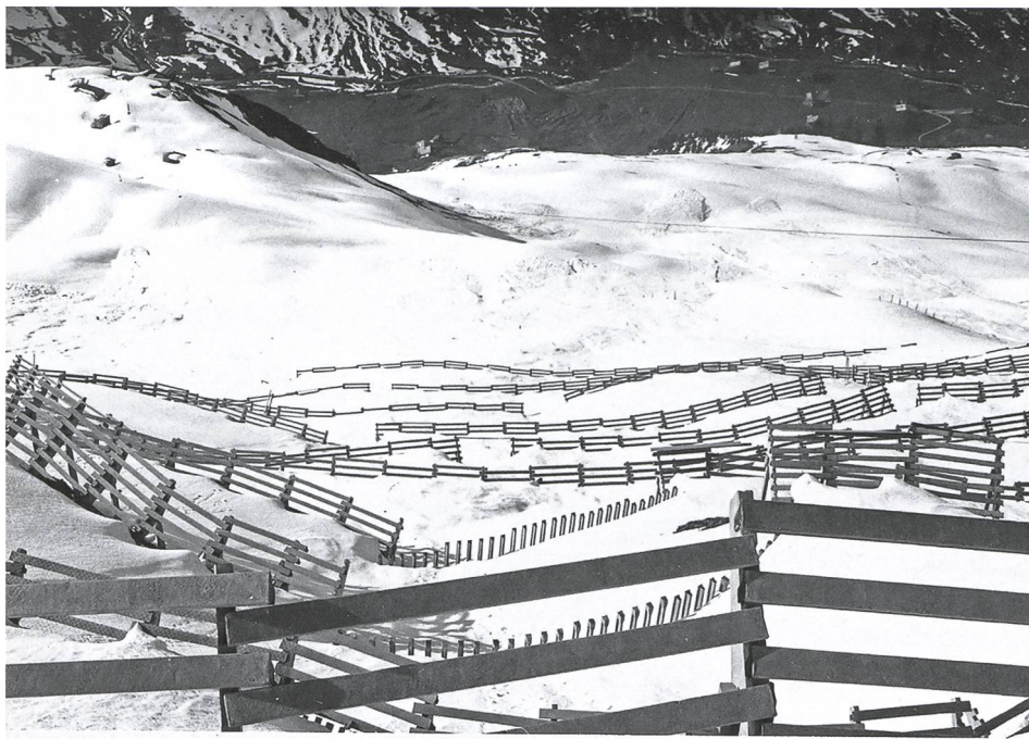
Abb. 29: Blick vom Kühnihorn- gipfel auf die Schneebrücken, teilweise mit Schneerechen ergänzt, 14. Mai 1966.* Alpi- nes Museum der Schweiz, ID 17/87 Nr. 2805; Nachlass Hans Frutiger.
