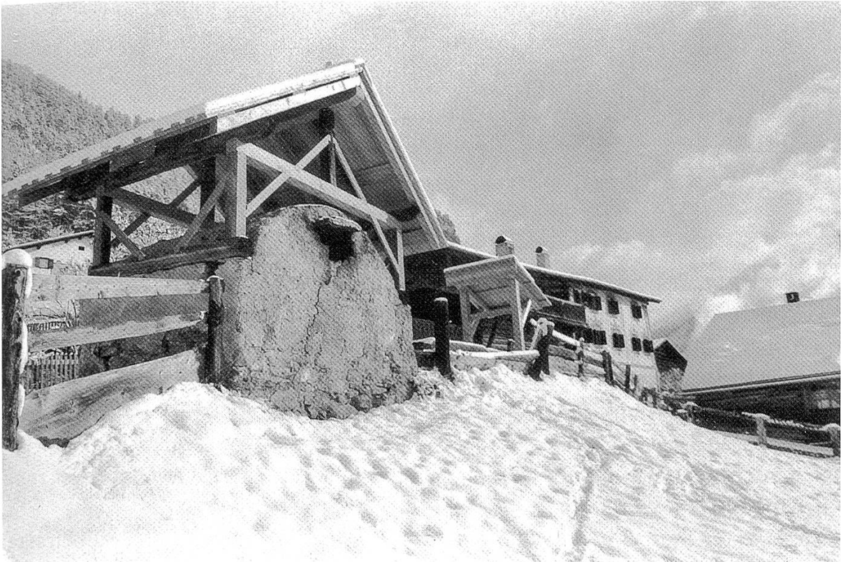
Abb. 3: Alvaneu, Back- und Waschhaus, im Hintergrund neue Brunnenüberdeckung, beide mit Lärchenschindeln gedeckt.
