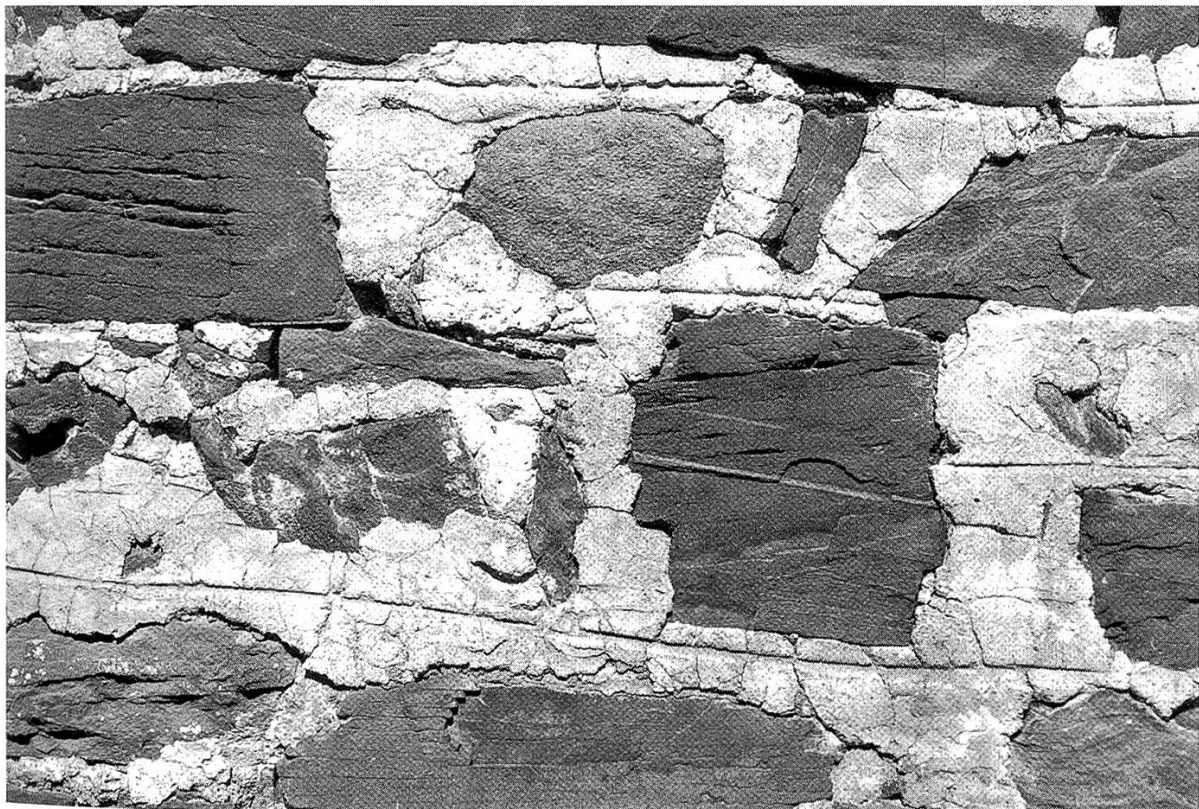
Abb. 19: Der «Pietra rasa»-Verputz mit horizontalem Fugenstrich am Turm (Phase 1).
