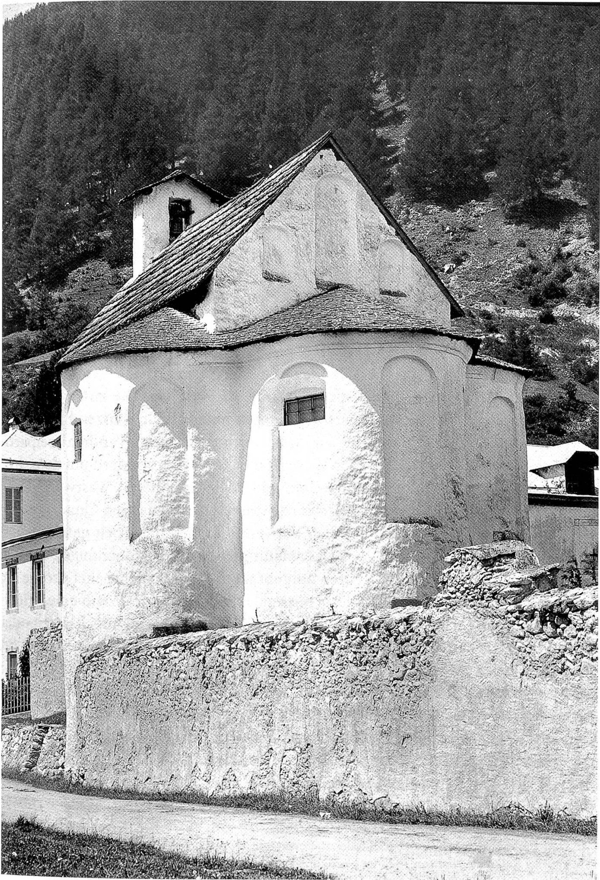
Abb. 10: Heiligkreuzkapelle mit Holzschindeldach; Aufnahme um 1910.
