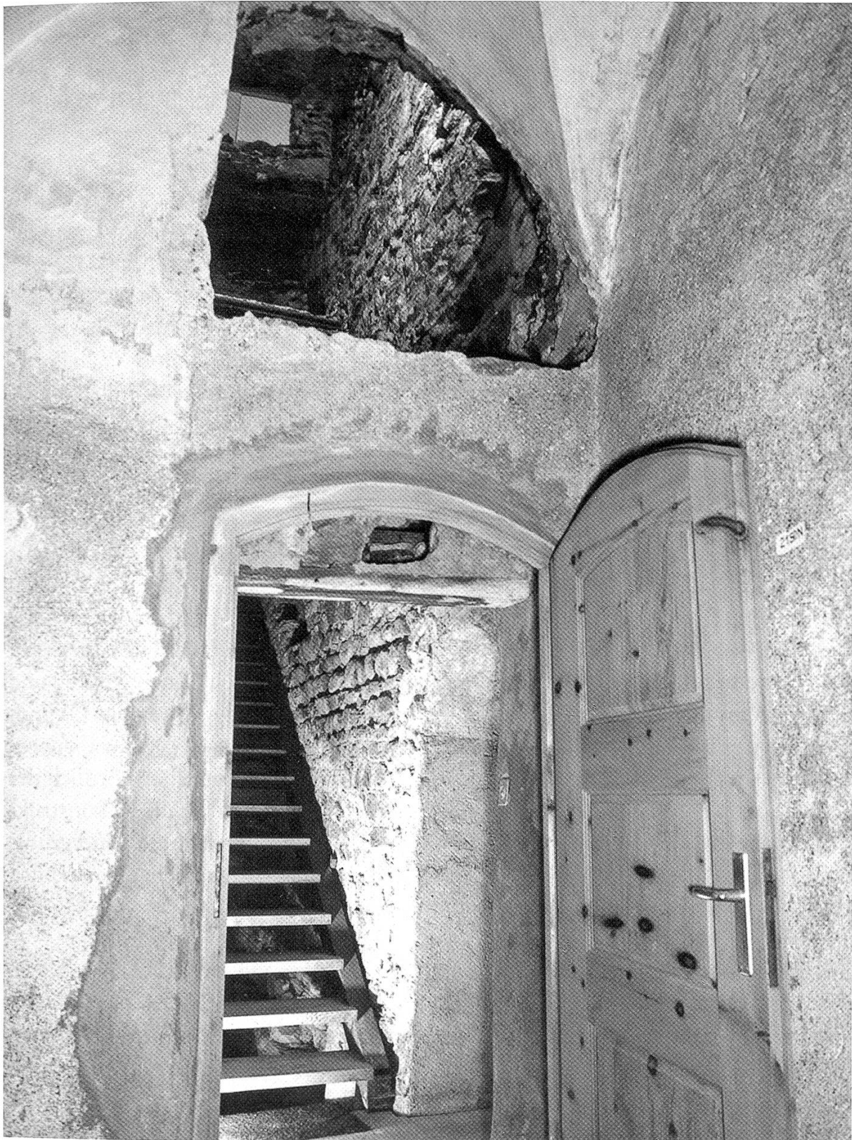
Abb. 3: Müstair, Kloster St.Johann; Bauuntersuchung Treppenschacht 1996: Blick gegen Süden in den Treppenschacht an das frühromanische Mauerwerk des Norpertraktes. Der obere, bisher unbekannte, abgemauerte Treppenschachtteil ist vom unteren Teil durch ein steigendes Gewölbe mit Treppentritten aus der Mitte des 16. Jahrhunderts getrennt.
