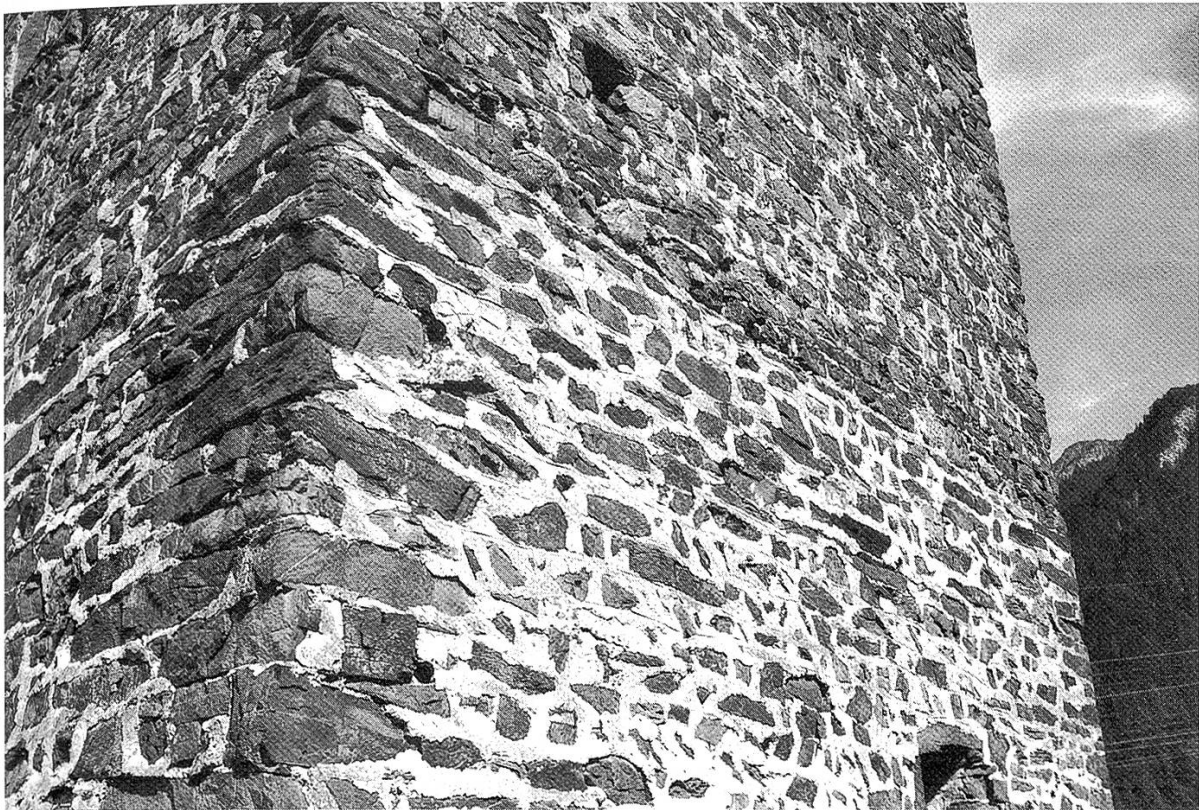
Abb. 18: Die horizontale Baunaht an der Südfassade zeigt die ursprüngliche Höhe des Turmes (Phase 1).
