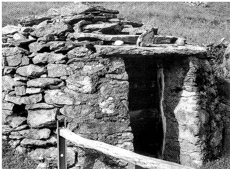
Abb. 75: Keller mit flachem Gewölbe
