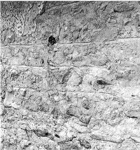
Abb. 34: Fugenstrichverputz an der Schauseite der Vorburg (Phase 2).
