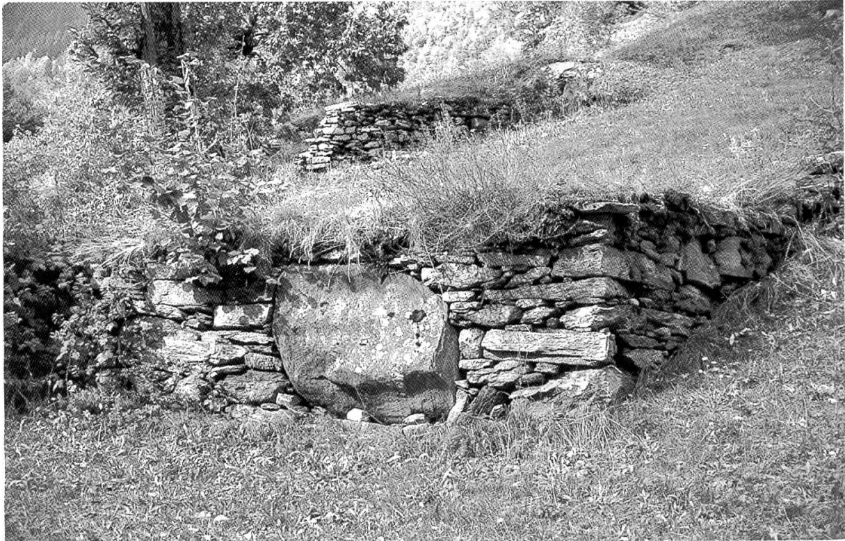
Abb. 15: Der Nutzungsdruck war in früheren Jahrhunderten im Gebiet von Soglio enorm hoch. Grössere Steine wurden ummauert und mit der dabei entstandenen Wiesenterasse war wieder ein Quadratmeter Kulturland gewonnen.
