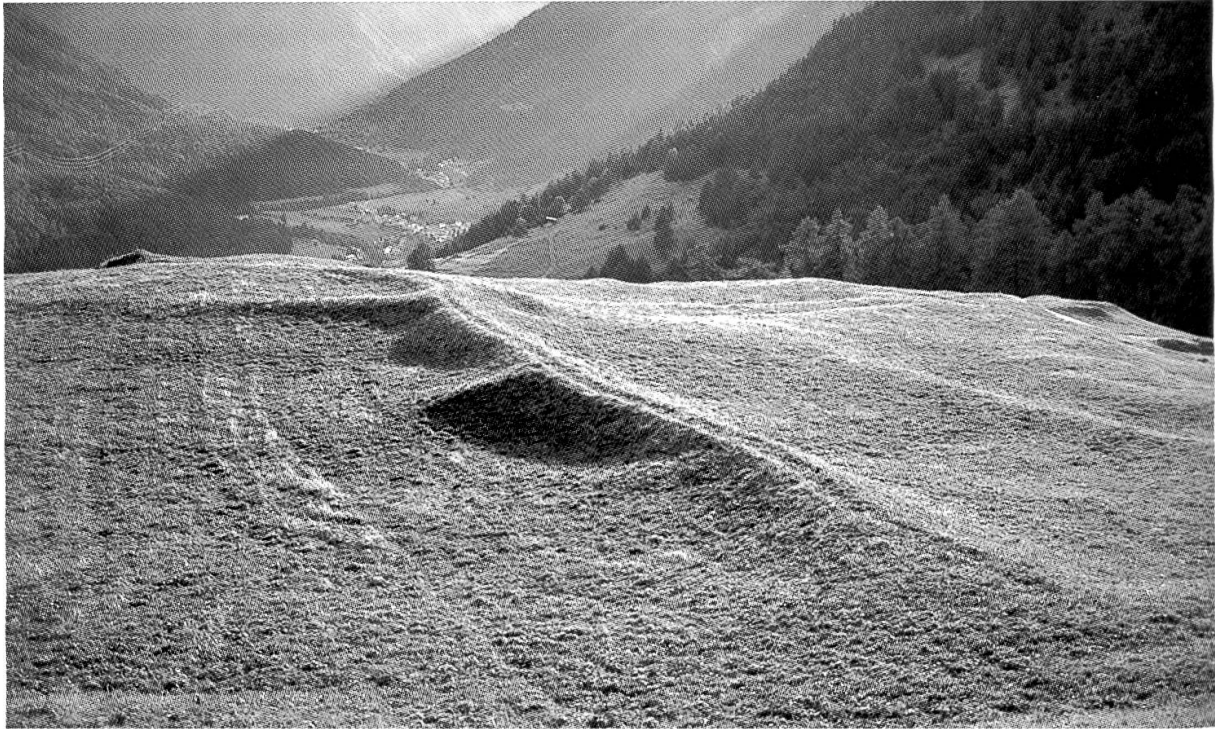
Abb. 23: Sämtliche Wiesen zwischen Giarsun und dem Val Tuoi wurden mehr oder weniger intensiv bewässert. Reste eines Bewässerungsgrabens mit kleinem Aquädukt bei Plan dad Ors.
