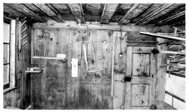
*Abb. 41:* Untervaz, Kronengasse 121/122 Stube mit Balkendecke von 1504, Täfer von 1713, zuletzt als Werkstatt verwendet.
