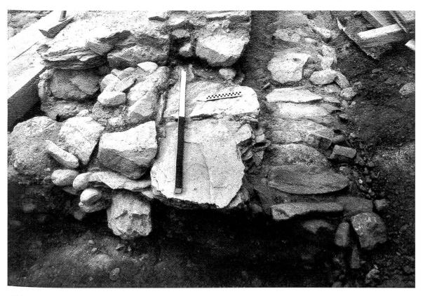
Abb. 17: Chur, Martinsplatz 1994/95; Reste eines gemauerten Wasserkanals aus der Zeit vor 1464. Ansicht von Westen.
