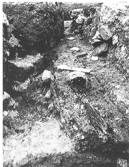
Abb. 10: Reste einer Holzteuchelleitung
