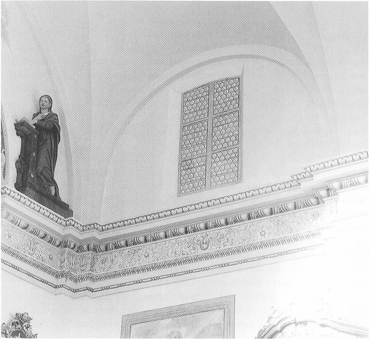
Abb. 38: Tinizong: Blindfenster mit Rundbleiverglasung an der Nordwand gegen den Turm
