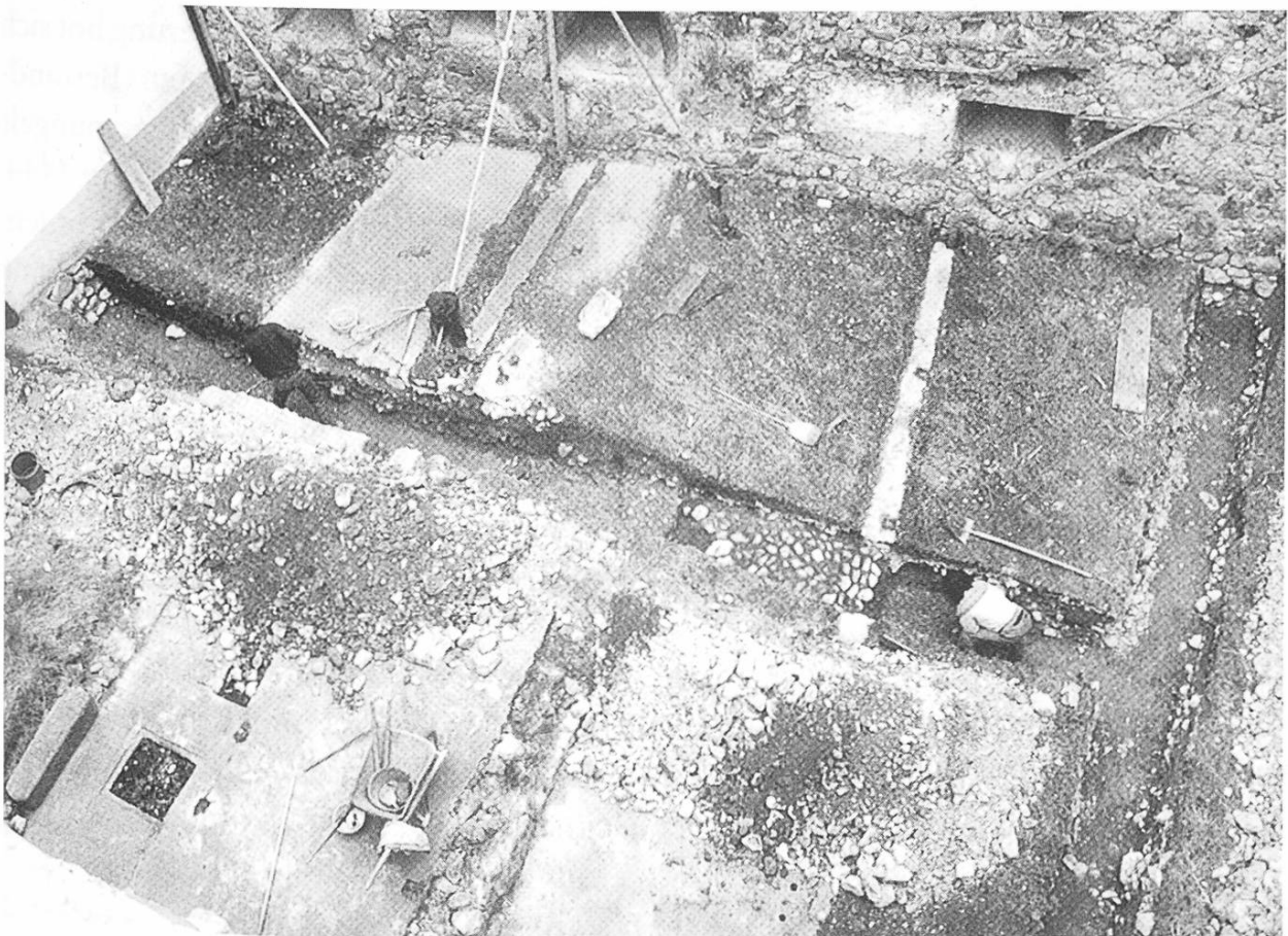
Abb. 20: Maienfeld, Vorderwinkel 83/84, Sondierungen im Bereich des ehemaligen Stalles: Unter den zemen- tierten Platten sind die ehemals gepflasterten Laufgänge zu erkennen ▼
