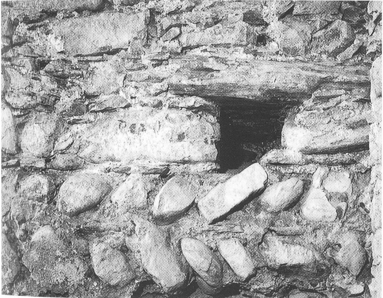
Abb. 25: Negativ eines Balkens zum neuen Wehrgang (um 1542), auf abgebrochene Mauer des 13. Jh. aufgelegt.
