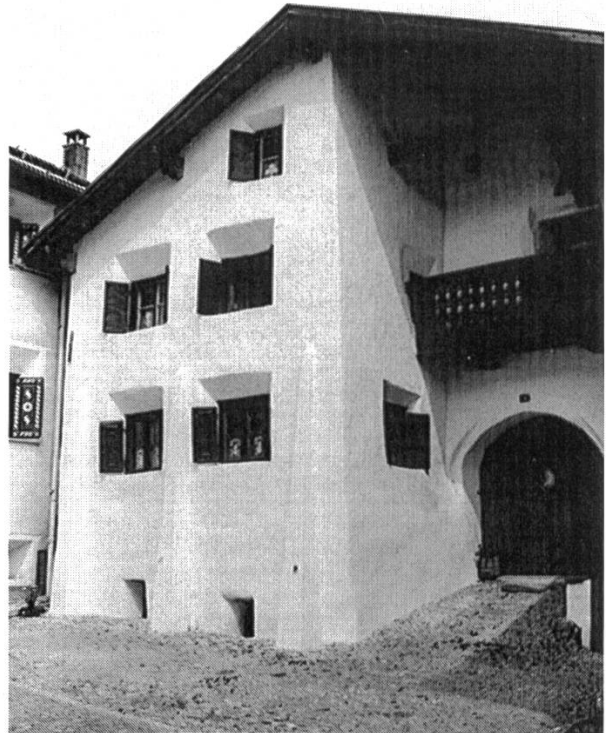
Abb. 2. Scuol, Haus à Porta, Nr. 36. Eingangsfassade.
