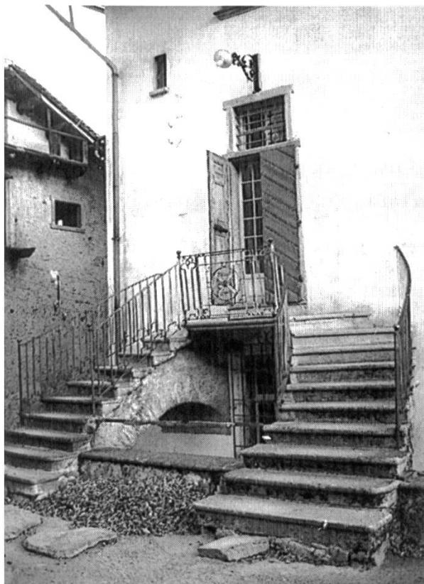
Abb. 6. Soglio, Casa Battista. Gartentreppe Rückseite.
