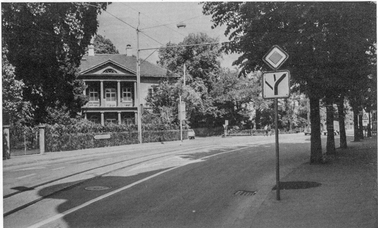
Die Villa Brunnengarten, erbaut 1848 von Martin Hatz. Soll eines der markantesten Baubeispiele klassizistischer Stadtvillen von Graubünden dem Verkehr geopfert werden?
