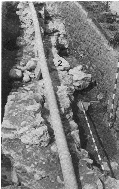
Abb. 7 Westmauer 1 Aufgehendes Mauerwerk 2 Rest des gotischen Mörtelbodens
