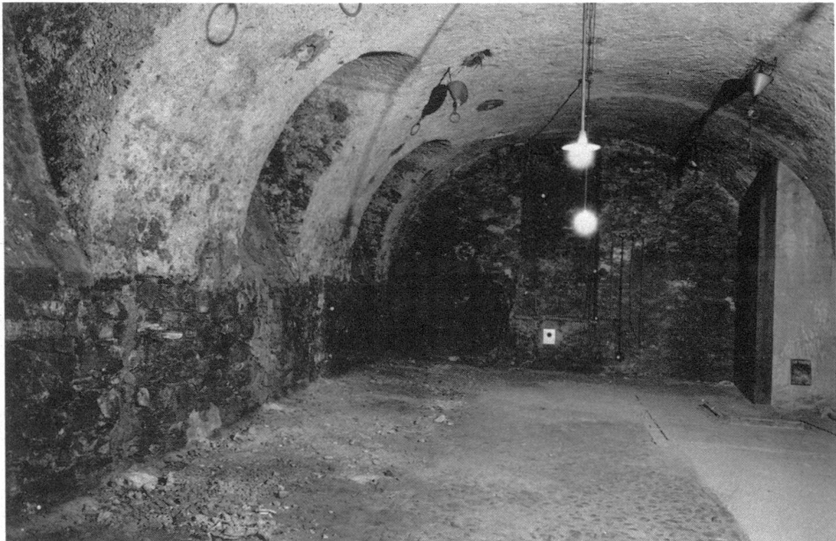
1 Kellerraum, vor der Restaurierung
