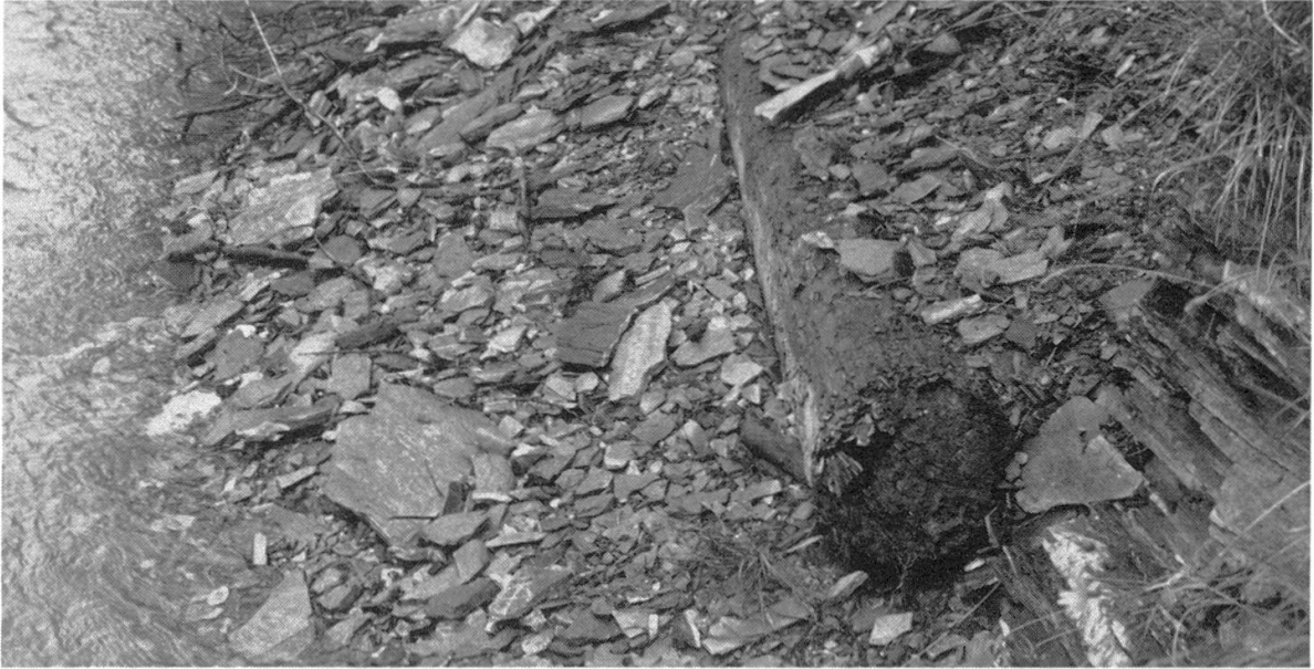
Abb. 23 Domat/Ems, am Fuss des Crap Taglieu neben den hochgehenden Hinterrhein: Überreste des Holzkastensystems des neuzeitlichen Weges entlang des Flusses. Der Weg wurde seit 1827 nicht mehr benutzt, da das äussere Domleschg damals bei Rothenbrunnen eine Brücke über den Rhein als Zugang zur neugebauten linksseitigen Kommerzialstrasse erhielt. Die Stelle des Balkens ist auf Bild 13 mit einem aufrechtstehenden Pfeil im Rhein markiert.
