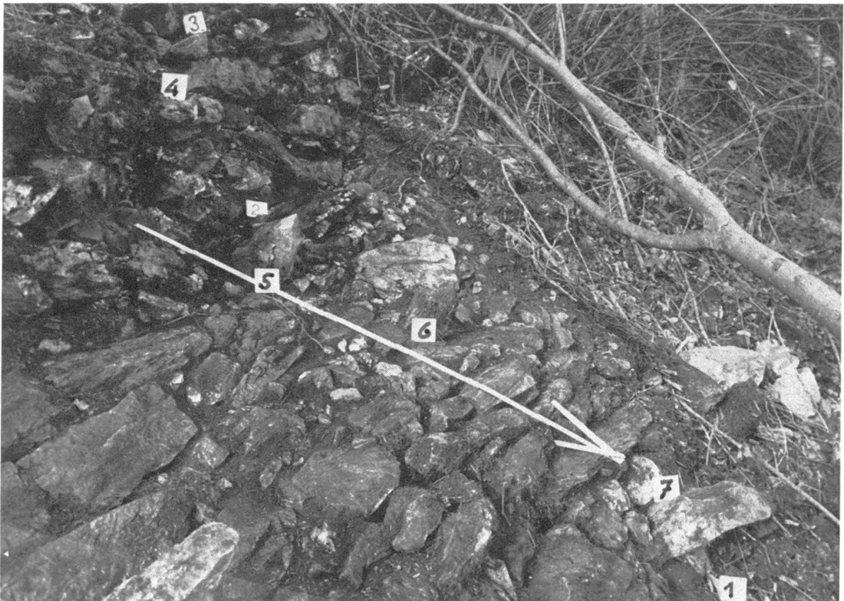
Abb. 28 Bonaduz, Isla (Koord. 751, 100 / 182, 250): Längs zum Hangansatz gibt es an verschiedenen Stellen dammartige Mauern. Diese hier wurde wahrscheinlich beim Bahnbau angelegt (1893), um den Hang zu stützen, auf keinen Fall als Schutz gegen den Rhein. Der einstige Weg muss entweder höher am Hang oder dem Talboden entlanggeführt haben.
