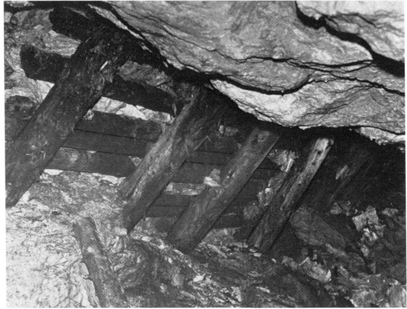
15 Mit Zimmerung abgestützter Versatz im Bergwerk Ursera.
