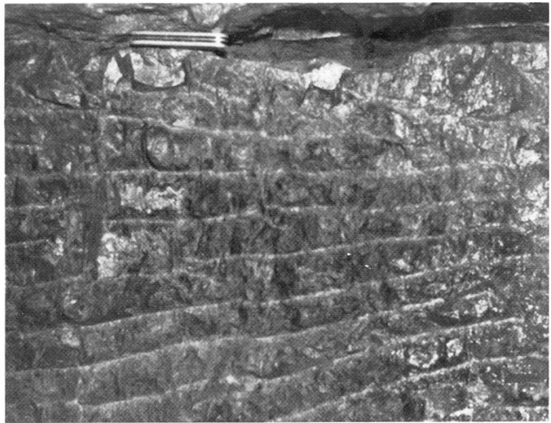
19 Schrämmspuren im Stollensystem «Obermadlein» in S-charl.
