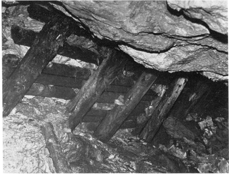
15 Mit Zimmerung abgestützter Versatz im Bergwerk Ursera.
