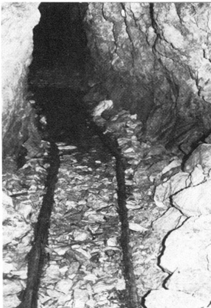
16 Holzschienen im Rebassostollen in Ursera aus dem Jahre 1865.
