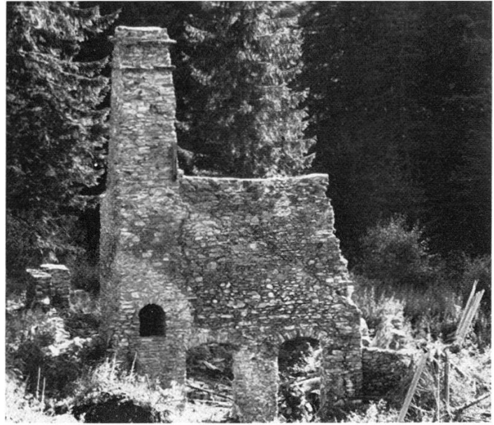
31 Aufbereitungs- und Verhüttungsgebäude der Val Sassam Mines Company in der Schmelze Ausser- ferrera. Blick gegen S.
