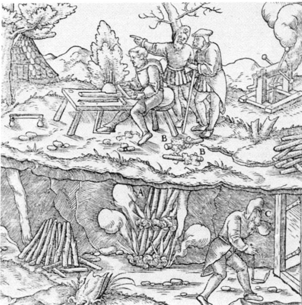
20 Feuersetzen nach Agricola, 1546.
