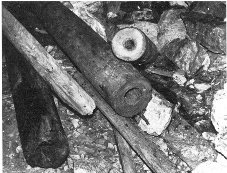
17 Überreste des Entwässerungssystems im Rebassostollen aus dem Jahre 1865. In der Bildmitte zwei Holzteucheln, links einfache Holzrinne.
