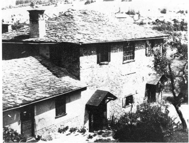
28 Südfront des Hauses Rosales in Andeer. Unterhalb des mittleren Fensters im zweiten Geschoss ist der Widerlagerstein für die Gichtbühnenrampe sichtbar.
