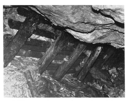
15 Mit Zimmerung abgestützter Versatz im Bergwerk Ursera.
