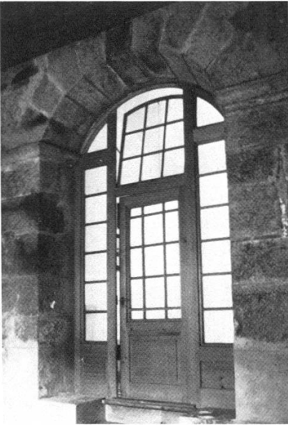
27 Gichtbühnentor des Blashochofens im Hause Rosales in Andeer.
