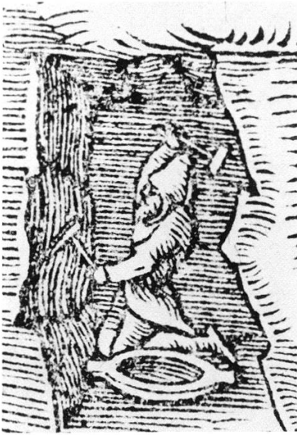
18 Schrämmarbeit nach Agricola, 1546.
