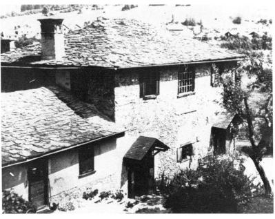
28 Südfront des Hauses Rosales in Andeer. Unterhalb des mittleren Fensters im zweiten Geschoss ist der Widerlagerstein für die Gichtbühnenrampe sichtbar.
