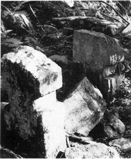
30 Widerlagerböcke für einen Schmie- dehammer in der Schmelze Ausser- ferrera.
