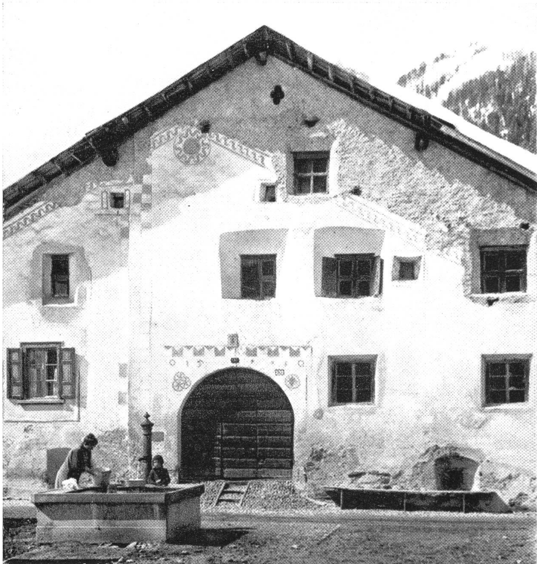
Foto 7 Zufahrtsrampe, chantporta , mit Stufen, s-chalinada , und primitiver Sitzbank in Zernezh. Alte Sgraffito-Motive (16. Jh.)
