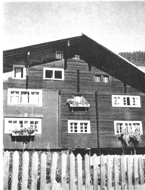
Foto 33 Zur Gewinnung zusätzlicher Kammern wird manchmal ein Dachflügel gehoben: das Haus steht schief. Ein Beispiel schlechter Aufstockung in Rueras (Tujetsch)
