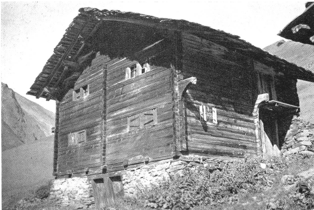
Foto 14 Laubenträger, mugrins-lautga , in Vrin-Puatsch. Die Laube fehlt
