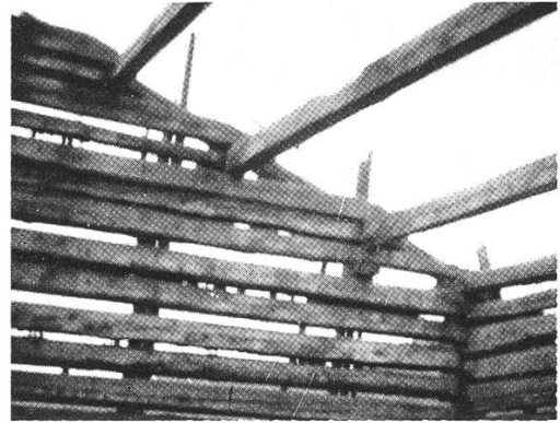
Foto 22 Charakteristisches Pfettendach an einem Heustall in Obervaz. Beim Abbruch aufgenommen
