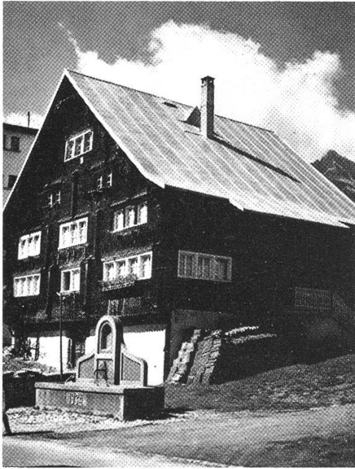
Foto 21 Das Pfarrhaus von Sedrun, gebaut nach dem Vorbild des Inner-schweizer Hauses: Steiles Dach mit Schifter (Knickung) und weißumrandeten Reihenfenstern
