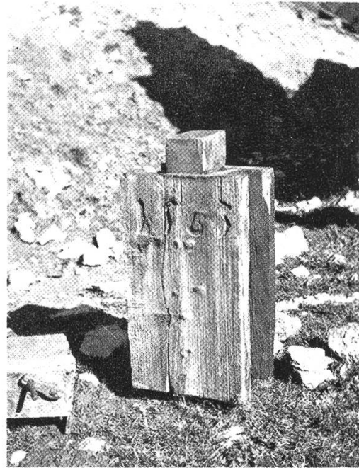
Foto 27 Heidenbalken aus dem Jahre 1563 aus Vals. Das Stück wird im Gandahus aufbewahrt. Man sieht den Zapfen und die Nut
