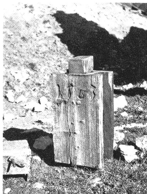
Foto 27 Heidenbalken aus dem Jahre 1563 aus Vals. Das Stück wird im Gandahus aufbewahrt. Man sieht den Zapfen und die Nut
