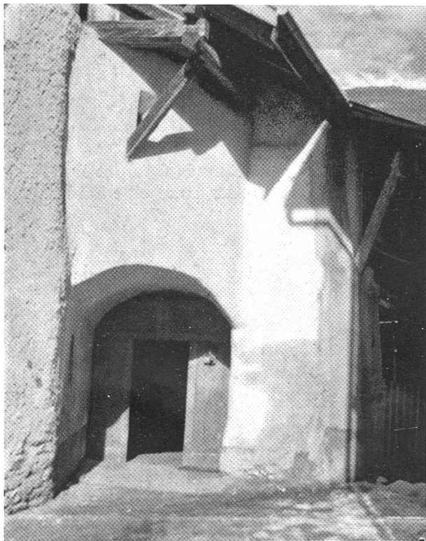
← Foto 10 Gewölbter Hauseingang sosta , in Savognin
