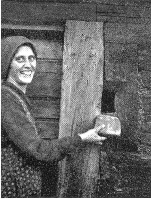
Foto 12 Wegnehmbarer Zapfen, al clop , in Livigno, durch dessen Öffnung man die Türe von außen aufmachen kann
