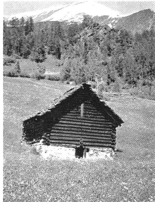
Foto 29 Feldstall in Lurengo (Leventina). Typisches Sparrendach aus rhombisch verschobenen, ziemlich dicken Steinplatten. Im Giebel ein «Heidenbalken»
