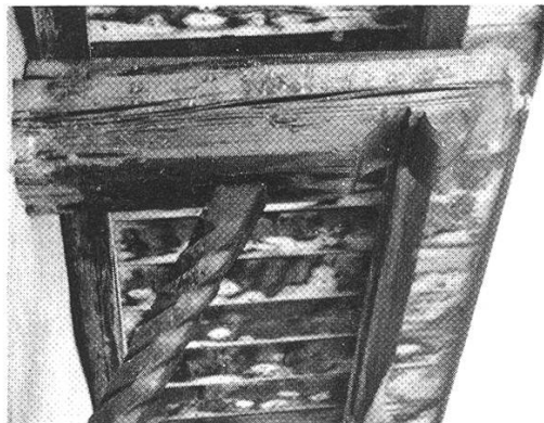
Foto 24 Kopfband und Pfette an einem Haus in Malans
