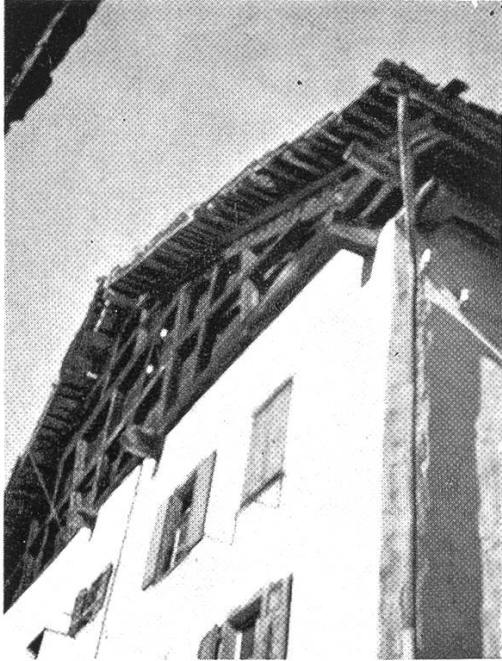
Foto 26 Giebel mit Bundwerk nach Tiroler Art in Savognin
