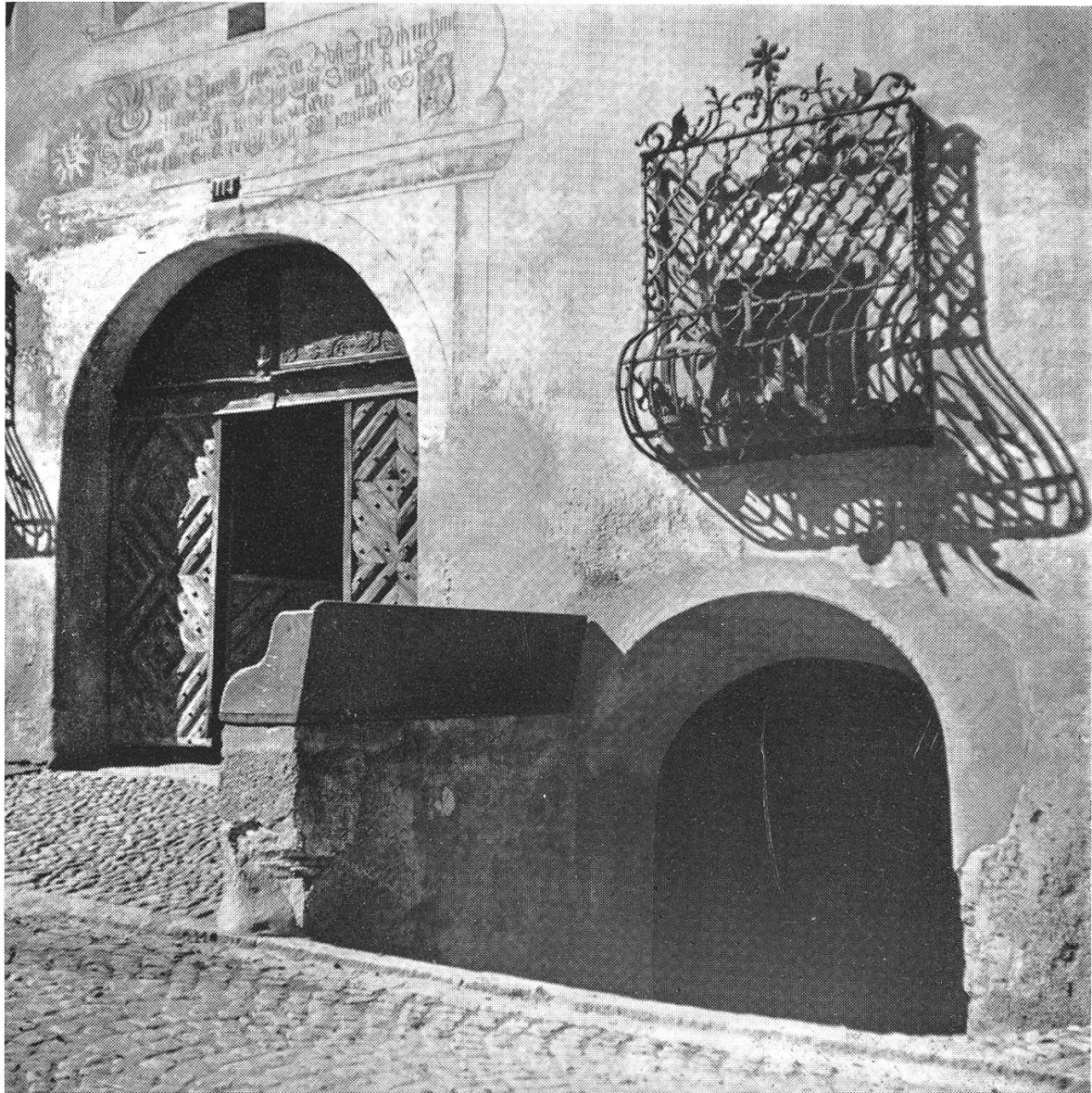
Foto 6 Hauseingang mit Sitzbank in Bergün; über der Einfahrt zur cuort ein mit geschmiedetem Korbgitter bewehrtes Fenster
