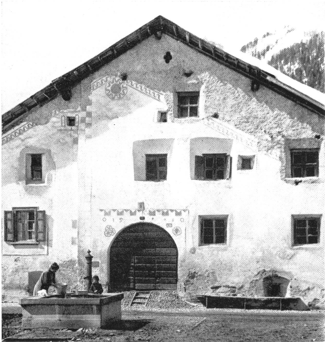
Foto 7 Zufahrtsrampe, chantporta , mit Stufen, s-chalinada , und primitiver Sitzbank in Zernezz. Alte Sgraffito-Motive (16. Jh.)
