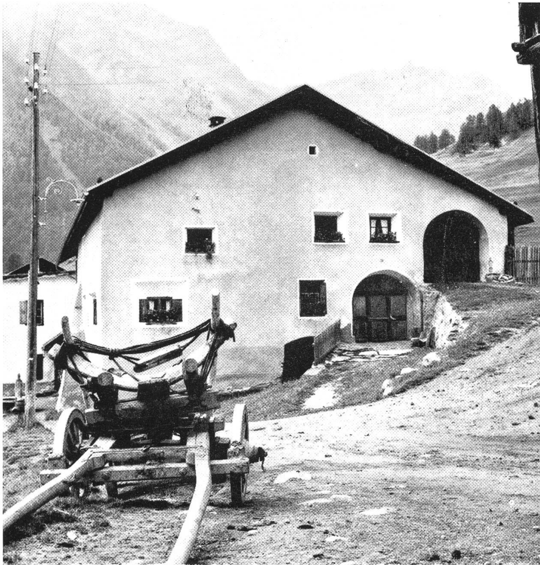
Foto 8 Ungewohnte Verteilung der Zugänge bei einem Haus in Guarda. Der Heustall hat seinen besonderen Eingang (rechts oben). Im Vordergrund eine Schleife für den Transport des Magerheus
