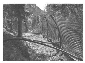
**Abbildung 4:** Steinschlagschutzbarriere. (Bild: Jakob AG)
