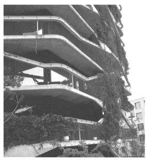
Abbildung 5: Fassadenbegrünung mit Stahlnetzen. (Bild: Hans Wiedemar)
