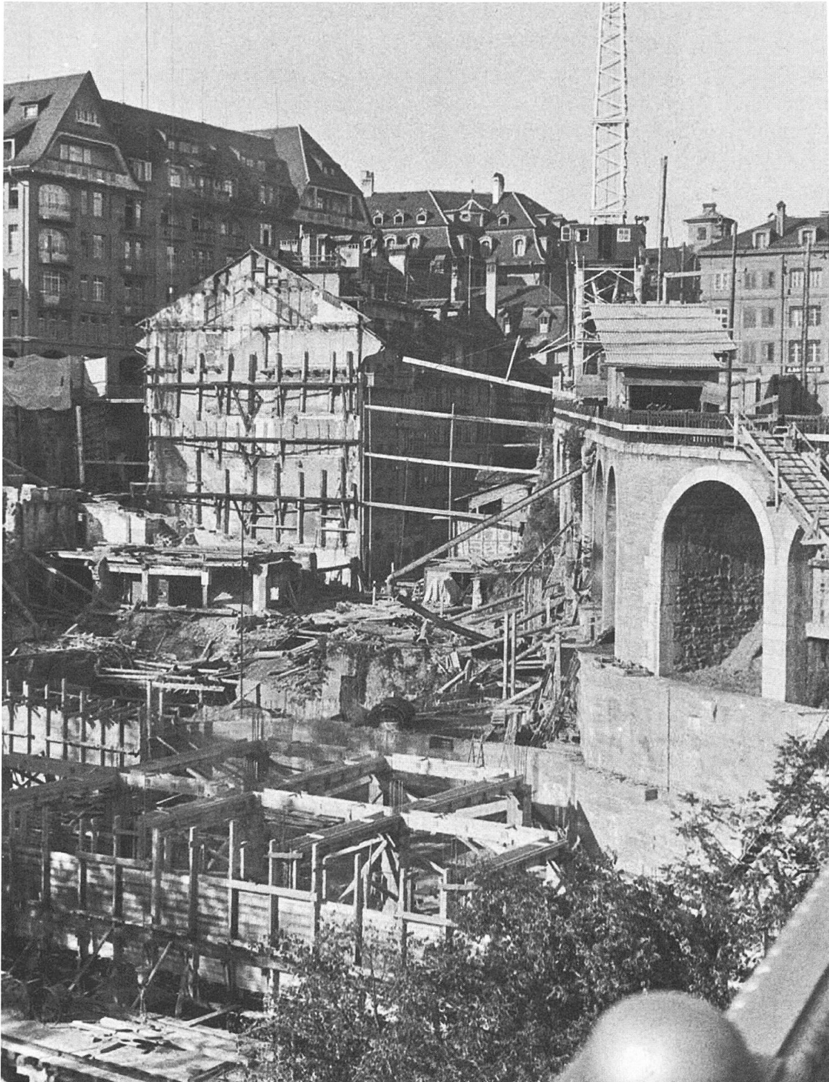
Abb. 1: Abbrucharbeiten im Gerbergraben und Aufbau der ersten Autogaragentiefgeschosse, Fotografie 1936
