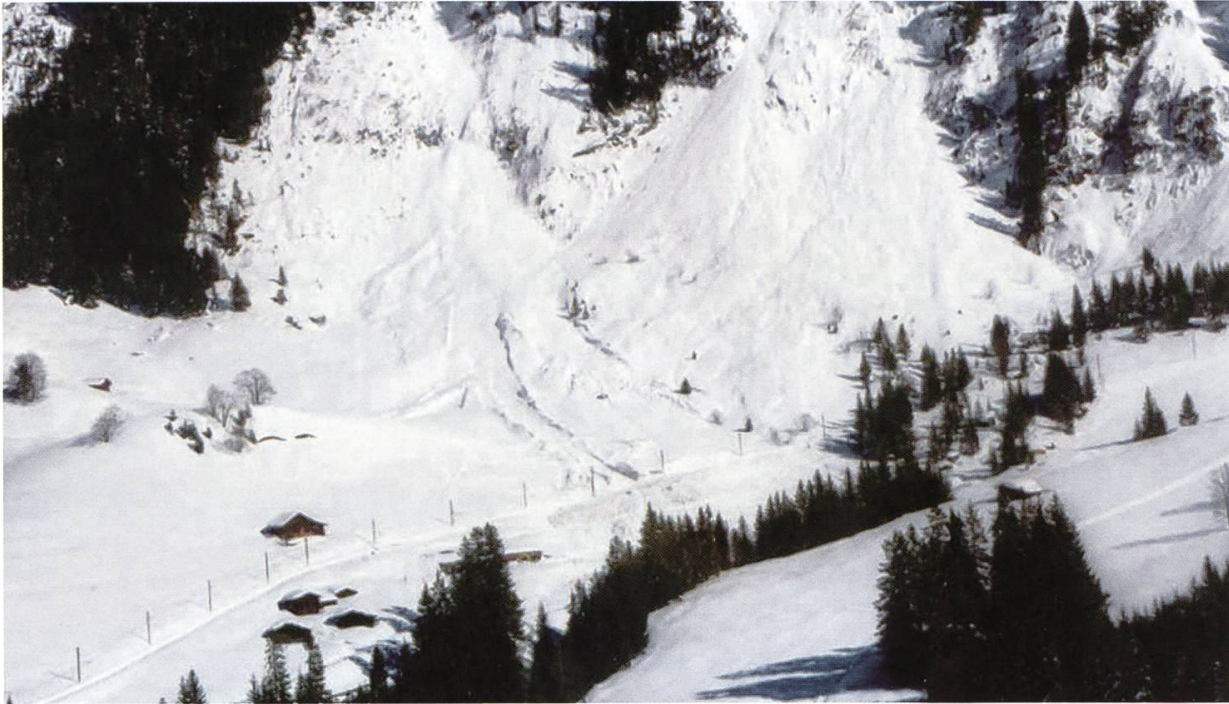
Abbildung 6: Zerstörtes Restaurant Oberland durch die Chläbischopflau (Foto: Kanton Bern, Amt für Wald, 1999)
