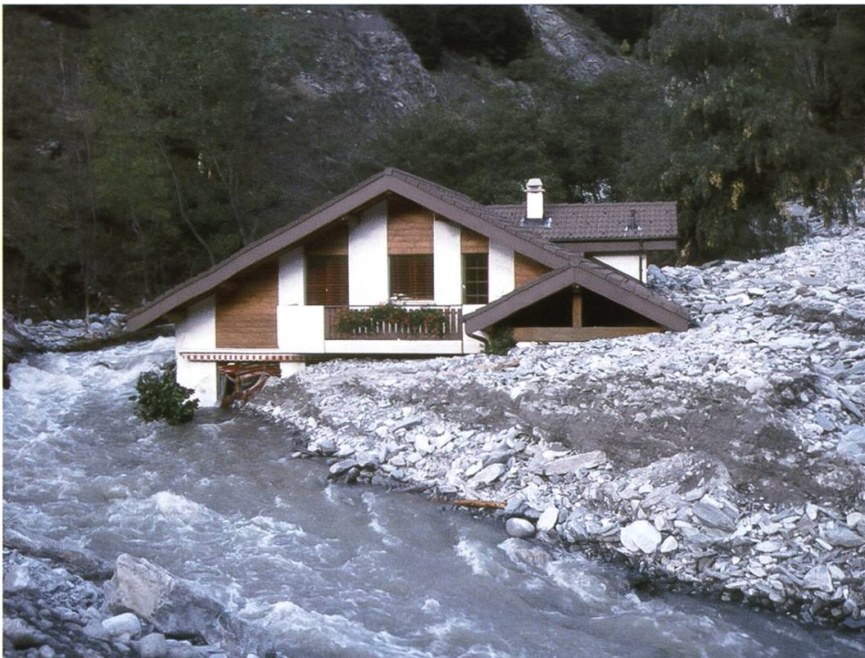
Abbildung 5: In Baltschieder wurden einzelne Gebäude meterhoch mit Geschiebe aus dem Baltschiederbach überführt. (Foto: PLANAT/BWG, 2000)
