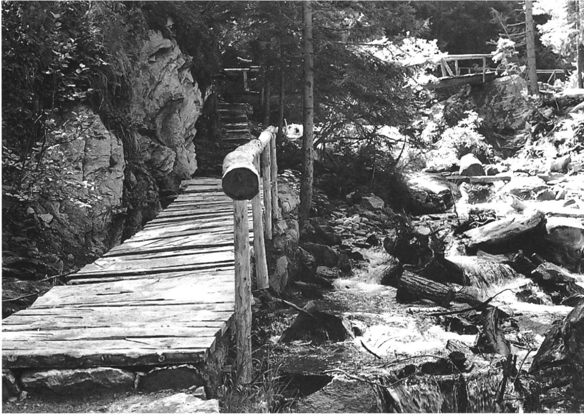
Abb. 2: Bei der Sanierung des Stockalperwegs wurden in der Tafernaschlucht neue Holzstege gebaut, die eine Passage in diesem Gebiet überhaupt erst möglich machen. (Foto: R. Flückiger)
