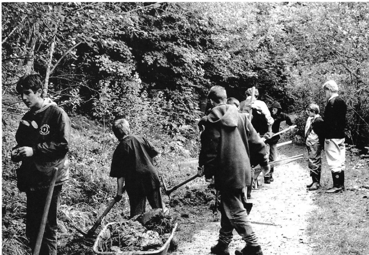
Abb. 13: Schüler beim Bau des Feuchtbiotopes bei der «Stucki-Quelle» (1995).
