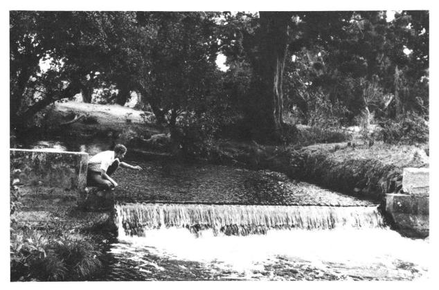
Abbildung 6: Die Messstelle Naro Moru-River 5 BC 2 gehört zum permanenten Abflussmessnetz. Sie ist ausgebaut als Rechteck-Wehrüberfall mit Lattenpegel, der täglich 2 mal abgelesen wird. Aufnahme Trokkenzeit August 1979.
