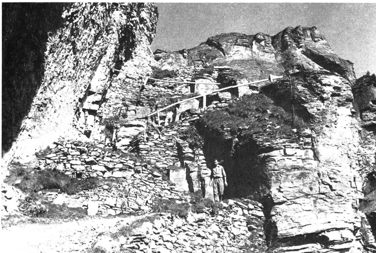
Fig. 19: Gemmi-Südseite: Warms Loch (AERNI 1971: Tafel 4, Ziff. 18). – Gebauter Weg von 1739–43, mit bautechnisch und topographisch ausgeglichener Steigung. Wegoberfläche kiesig, Randpflaster steil eingesetzt. Stützmauern aus Bruchsteinen in wildem Verband und mit vorwiegend horizontal liegenden Längsachsen. An einigen Stellen ist Zement in die Fugen gestrichen. In Figur 20 ist ein steingerecht gezeichneter Ausschnitt aus dem Raum des ersten Holzpfostens vom linken Bildrand her dargestellt.
