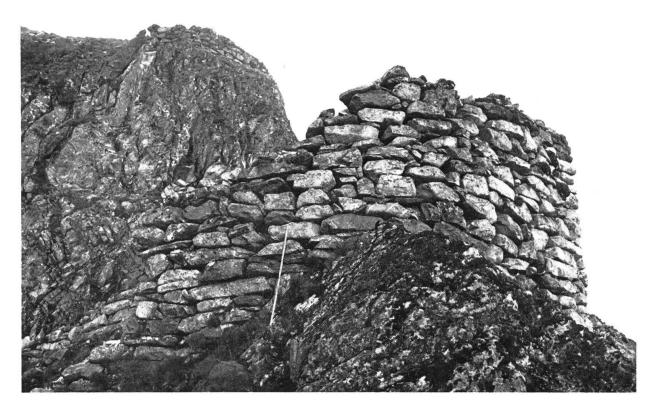
Fig. 16: Lötschen-Nordseite: Wegkehre in der "Unteren Felswand" (AERNI 1971: Tafel 5, Ziffer 26, A 35). Überrest einer Wendeplatte aus den Jahren 1696/97. Die Höhe beträgt im Maximum noch 3 m. Die Stützmauer besteht aus einem hammerrechten Schichtenmauerwerk, dessen Aussensteine ursprünglich mit Mörtel verbunden waren. Vergleichsstrecke 2 m. Aufnahme vom 8.9.1961.
