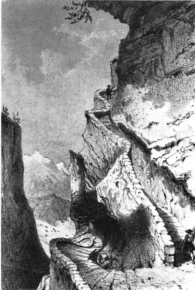
Fig. 18: "Chemin de la Gemmi près de Louèche les Bains". – Der Zeichner stand beim "Chlöfe" (AERNI 1971: Tafel 4, Ziffer 22, A 60). Sehr deutlich sind die künstliche Einsprengung des Weges und die zum Schutz der Passierenden angebrachten Seitenmauern dargestellt. Es scheint, dass die heute üblichen Holzzäune damals nicht bekannt waren.
