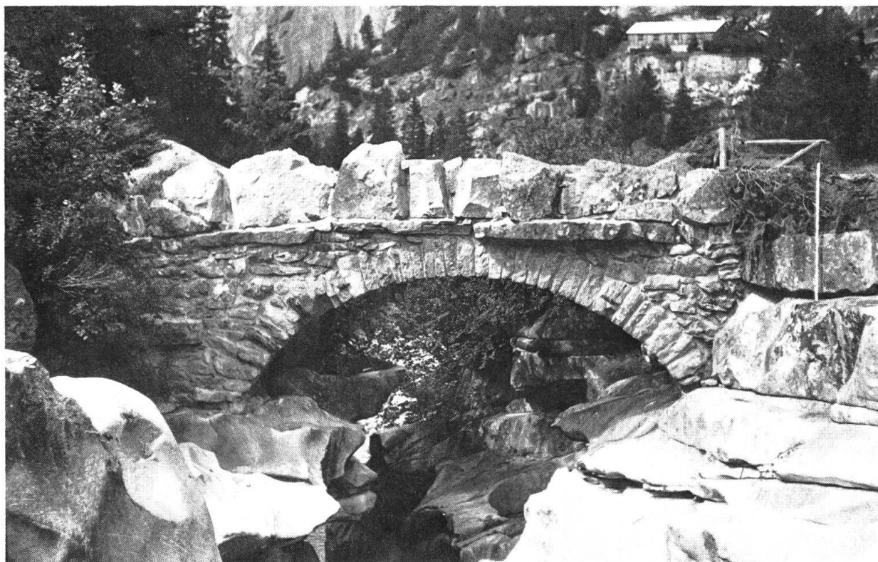
Fig. 13: Grimsel-Nordseite: Kleine Böglisbrücke in Kunzentännlen (AERNI 1971: Tafeln 8 und 9, Ziff. 38, A 46). – Die steinerne Gewölbebrücke hat eine Spannweite von 6,3 m und einen Bogenstich von 2 Metern. In der bloss 2–4 Meter breiten Klamm zeugen wundervolle Kolkerscheinungen von der Erosionsarbeit der Aare, die sich hier etwa 12 Meter in den Granit eingetieft hat (vgl. Fig. 14). Vergleichsstrecke am rechten Bildrand: 2 Meter. Standort: 667 625 / 161 000 / 1570 m; Bildmitte Az 6400 A ‰. LK 255
