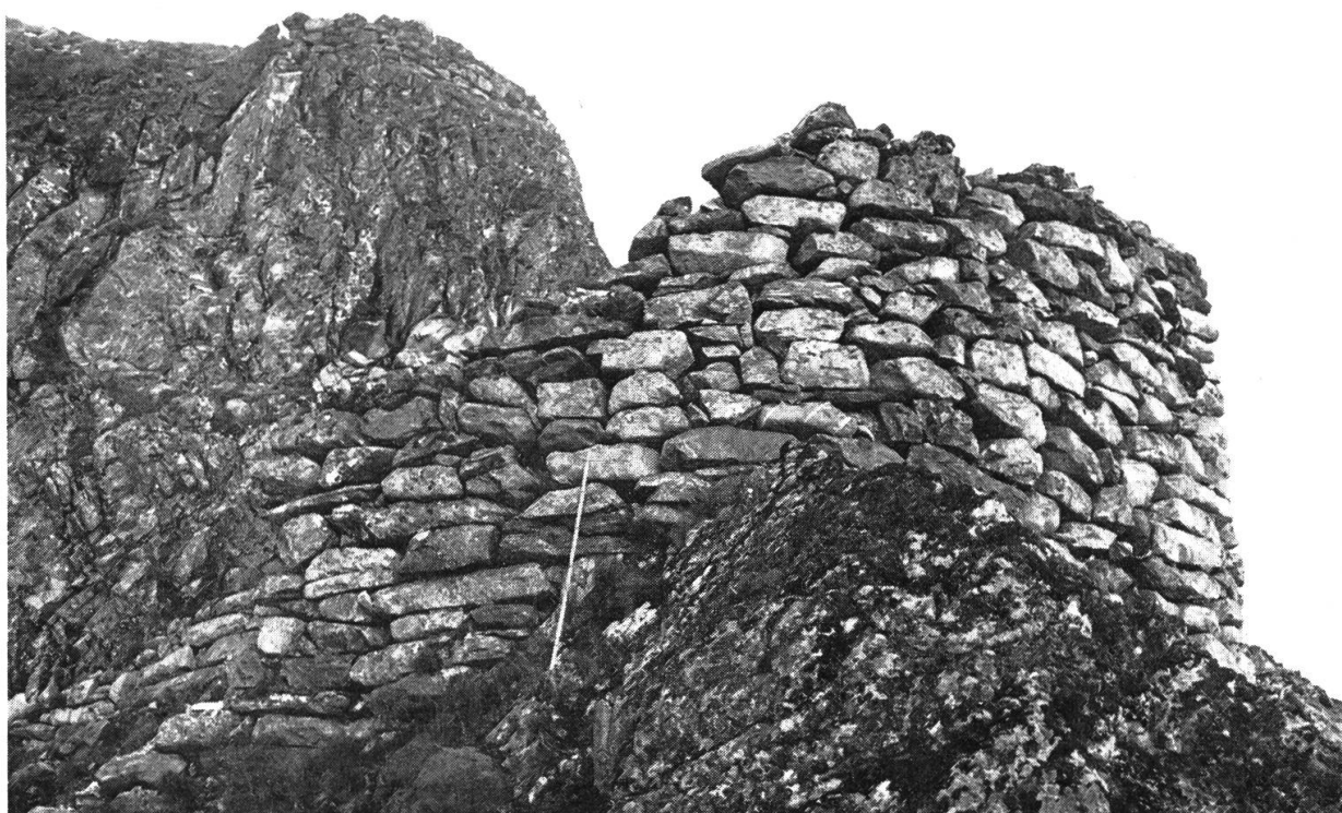
Fig. 16: Lötschen-Nordseite: Wegkehre in der “Unteren Felswand” (AERNI 1971: Tafel 5, Ziffer 26, A 35). Überrest einer Wendeplatte aus den Jahren 1696/97. Die Höhe beträgt im Maximum noch 3 m. Die Stützmauer besteht aus einem hammerrechten Schichtenmauerwerk, dessen Aussensteine ursprünglich mit Mörtel verbunden waren. Vergleichsstrecke 2 m. Aufnahme vom 8.9.1961. Anlässlich der Begehung vom September 1969 musste ich feststellen, dass die Mauerecke im rechten Bildteil zwischen 1964 und 1969 abgestürzt ist. Standort: 621 370 / 140 975 / 2350 m; Bildmitte Az 2600 A ‰. LK 264
