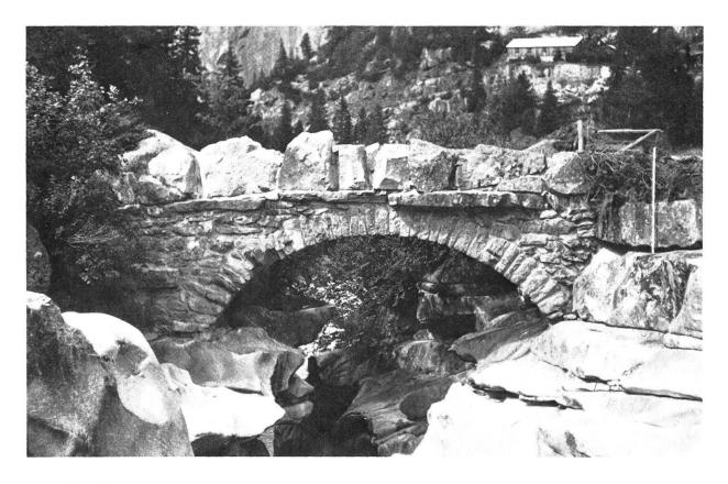
Fig. 13: Grimsel-Nordseite: Kleine Böglisbrücke in Kunzentännlen (AERNI 1971: Tafeln 8 und 9, Ziff. 38, A 46). – Die steinerne Gewölbebrücke hat eine Spannweite von 6,3 m und einen Bogenstich von 2 Metern. In der bloss 2–4 Meter breiten Klamm zeugen wundervolle Kolkerscheinungen von der Erosionsarbeit der Aare, die sich hier etwa 12 Meter in den Granit eingetieft hat (vgl. Fig. 14). Vergleichsstrecke am rechten Bildrand: 2 Meter.
