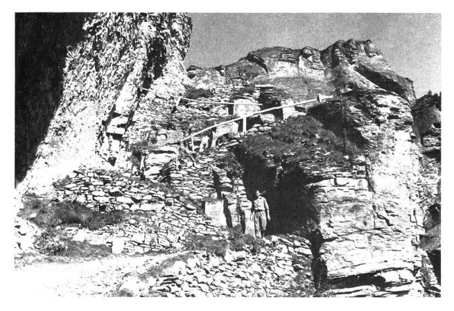
Fig. 19: Gemmi-Südseite: Warms Loch (AERNI 1971: Tafel 4, Ziff. 18). — Gebauter Weg von 1739—43, mit bautechnisch und topographisch ausgeglichener Steigung. Wegoberfläche kiesig, Randpflaster steil eingesetzt. Stützmauern aus Bruchsteinen in wildem Verband und mit vorwiegend horizontal liegenden Längsachsen. An einigen Stellen ist Zement in die Fugen gestrichen.
