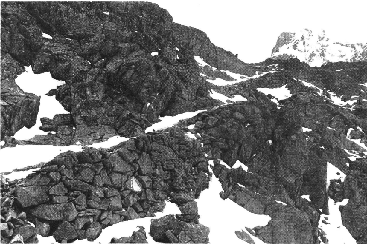
Fig. 4: Lötschen – Nordseite: Weg durch die “Obere Felswand” (AERNI 1971: Tafel 5, Ziffer 33, A34): Im Mittelgrund gebauter Weg aus der Zeit vor 1698, mit bautechnisch und topographisch ausgeglichener Steigung. Im Hintergrund des Ferden-Rothorn. Wegoberfläche mit Steilrandpflaster, bergseits in Blockpflaster und Feinmaterial übergehend, Wegbreite 2,2 m und mehr. Stützmauern aus Bruchsteinen in wildem Verband und ungeordneter Lagerung der Steinlängsachsen. Stadort: 621 110 / 140 075 / 2600 m; Bildmitte Az 3600 A ‰. LK 264
