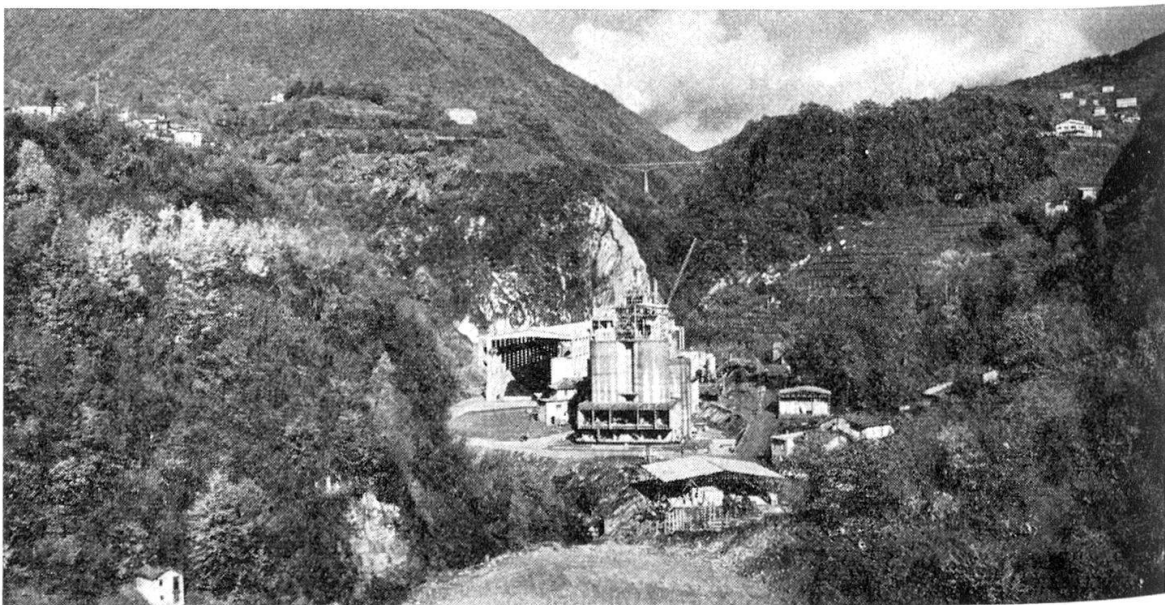
Abbildung 8 Blick von S gegen die Mündungsschlucht der Breggia. Links oben die Häuser von Ponte und Castel S. Pietro. Auf der Höhe der Zementfabrik ist links die Ponterinne und rechts diejenige des Nebenbaches von S. Martino zu sehen. In der Mitte des untern Bildrandes die künstlich planierte Scagliafläche mit einer nordwärts bis zur Zementfabrik verfolg- baren Moräne. Den Horizont bildet das asymmetrische Querprofil des südlichsten Teiles des Muggiotales.
