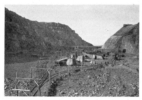
Aufnahme I: Abbaustelle am Kirunavaara mit Geleiseanlagen zur Aufnahme des Erzes und Sprengschutzhütten. 1948. Photo: P. Köchli
