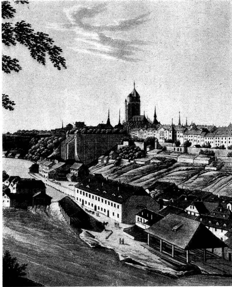
Bild 1. Ansicht von Bern vom Aargauer Stalden aus, um 1850. Über die geschlossene Front der Stadt ragt neben den 40 m hohen Mauern der Münsterterrasse das Münster empor. Im Vordergrund, am Ufer der Aare, Wasserwerke, gewerbliche Anlagen und Wohnhäuser der Matte.
