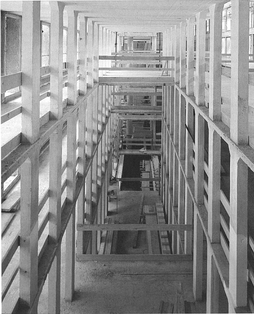
Ausschachtung für die Treppenanlage
