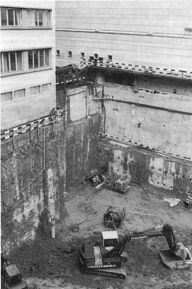
Die Baugrube Ende 1994
