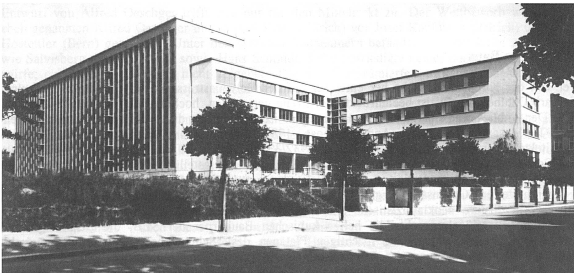
Ansichten von Nordwesten: im Vordergrund die Bernastrasse, links das achtgeschossige Büchermagazin, im Erdgeschoss die offene Leseterrasse
