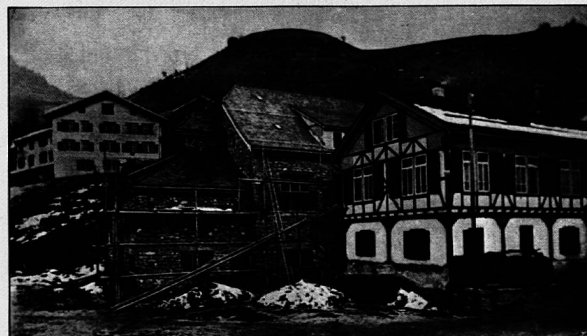
Die Turnhalle im Rohbau 1909
